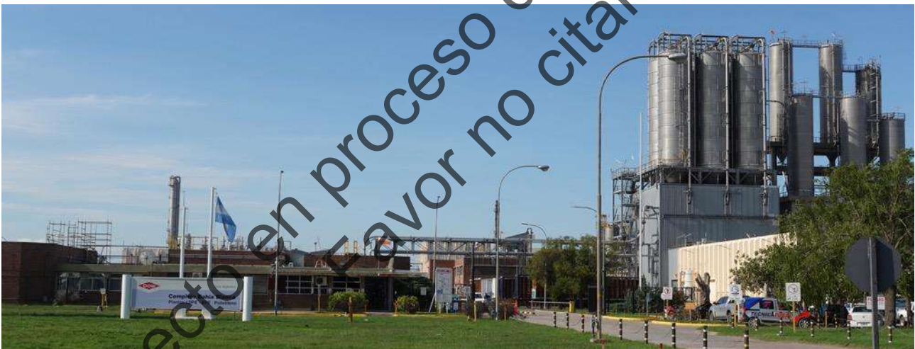
Figura 204. Instalaciones de Dow Argentina, Polo petroquímico Bahía Blanca.
