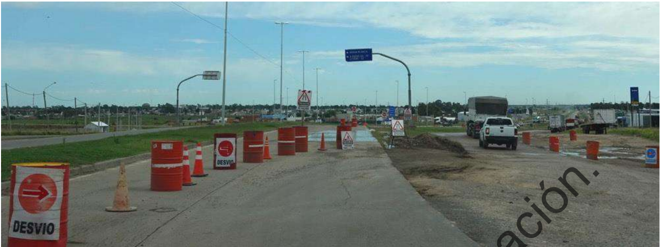
Figura 213. Corte por obras post-inundación en Autovía Juan Pablo II (Av. Circunvalación Norte) y Av. Circunvalación Juan Manuel de Rosas.
