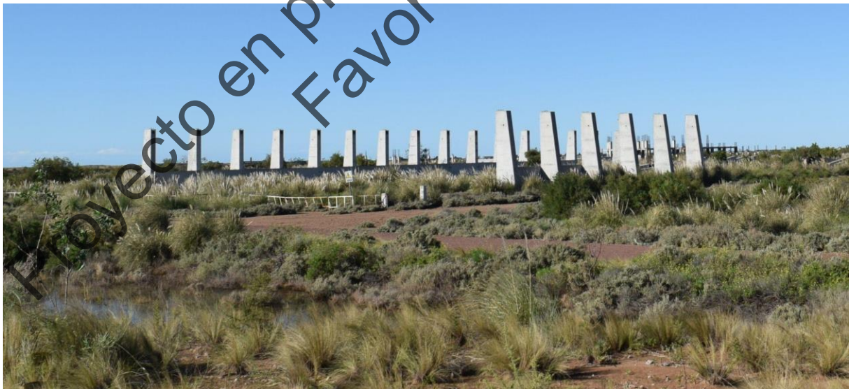
Figura 24. Parcela con pilotes de concreto.
