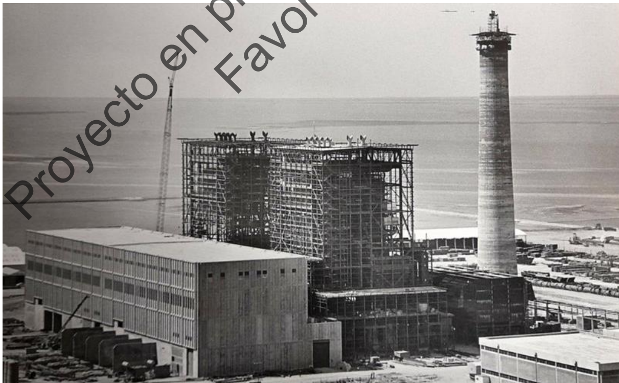
Figura 10. Central Termoeléctrica Luis Piedrabuena durante su construcción. Fuente: Minervino (2023).
