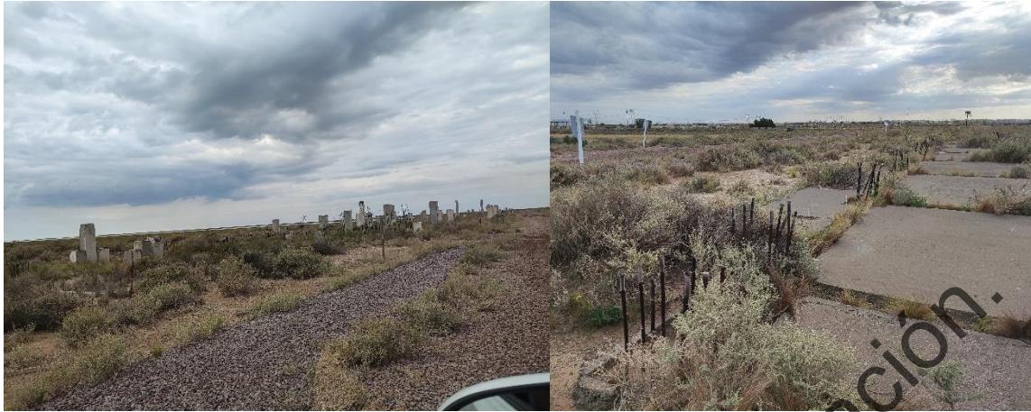
Figura 25. Vista de pilotes y estructuras civiles construidas por VALE, en lateral este del camino de viaducto.
