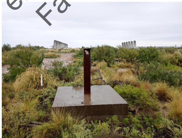
Figura 20. Vieja cámara séptica de las obras de VALE, ubicada en el norte del predio.
