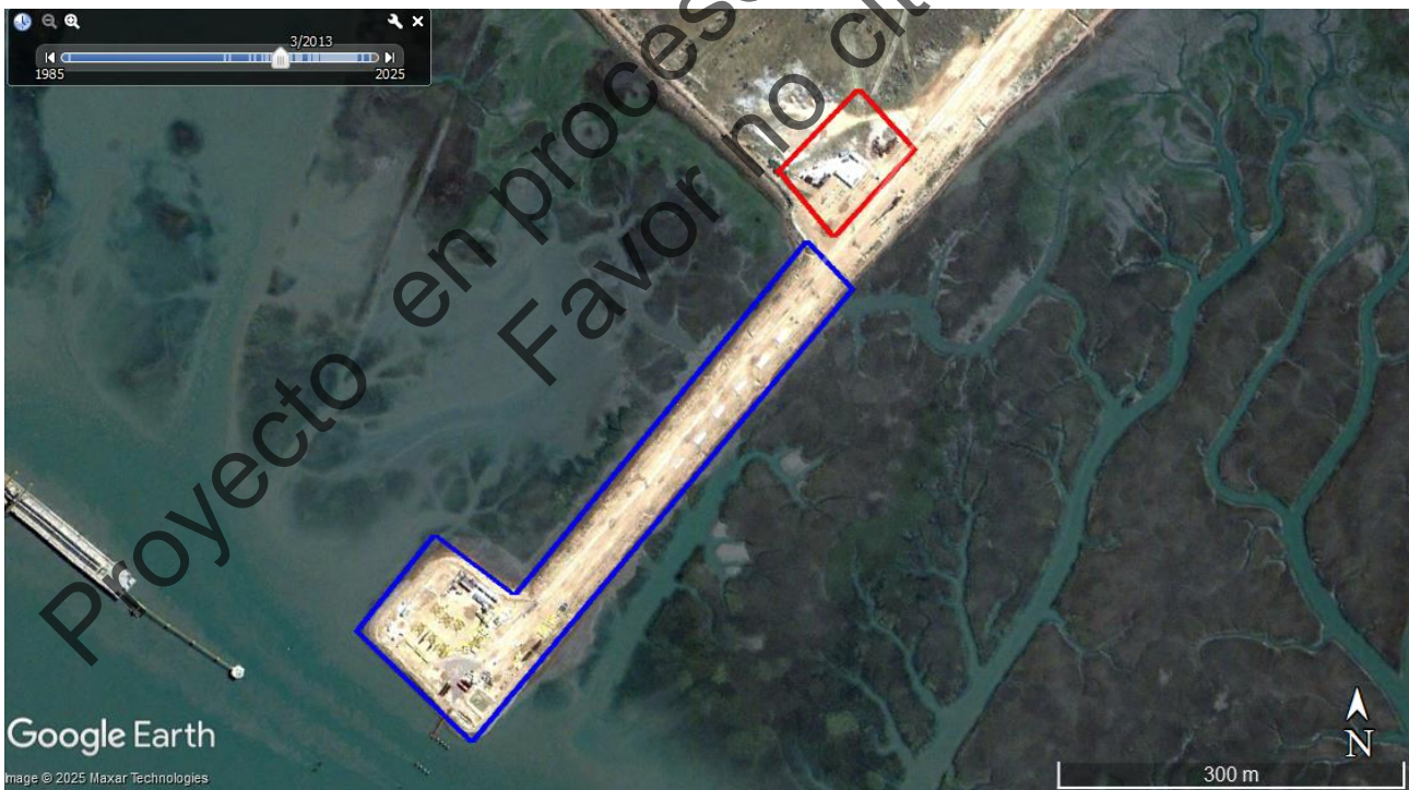
Figura 7. Imagen satelital del sector de viaducto y macizo (en azul) tomada en marzo de 2013. En rojo se delimita un sector de obrador.
