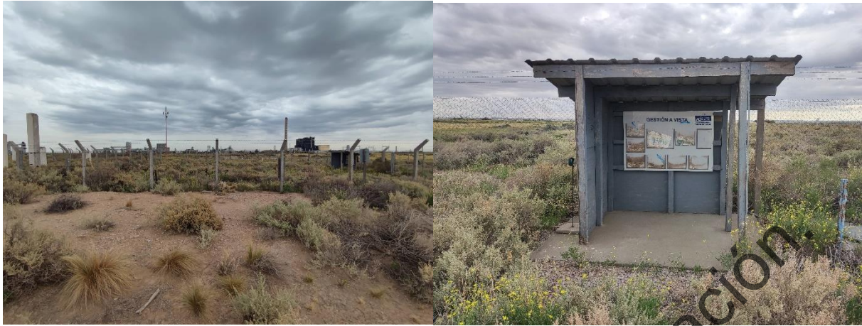
Figura 27. Obrador secundario de las obras de VALE en sector cercano a viaducto.
