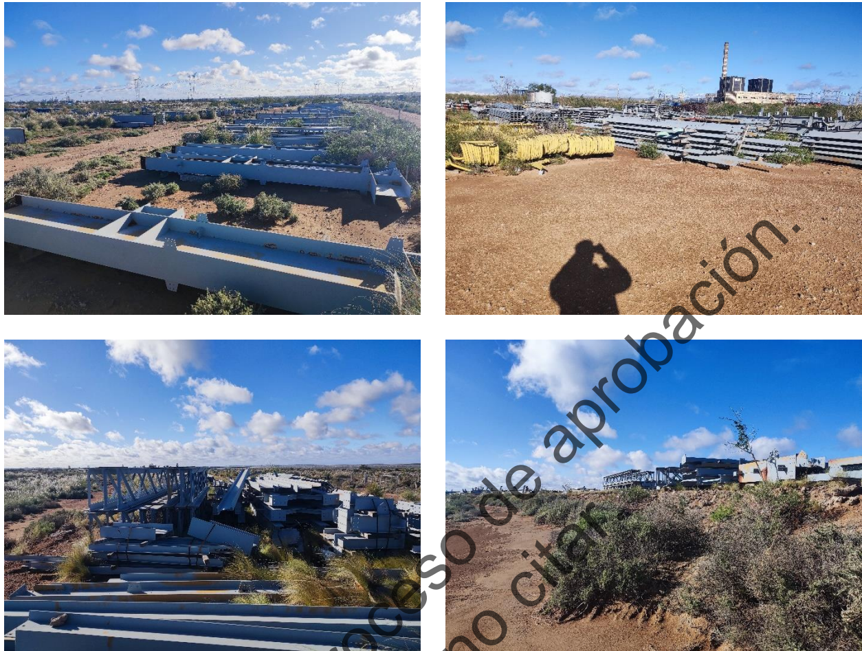
Figura 24. Estructuras metálicas abandonas luego de las obras de VALE.
