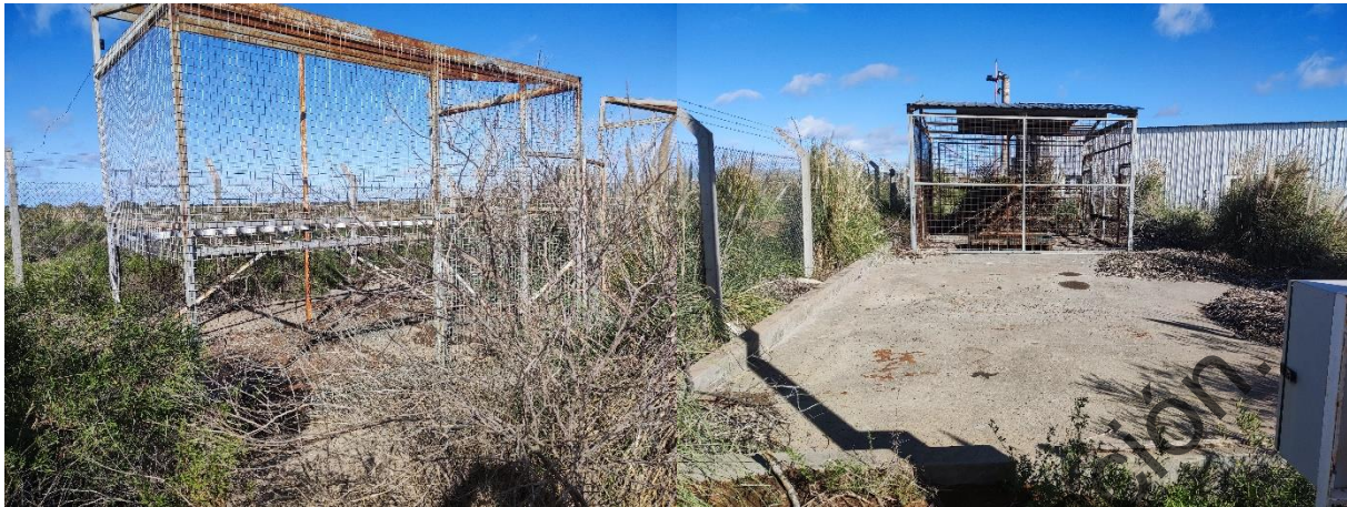
Figura 14. Almacenes vacíos en sector de obrador de VALE.
