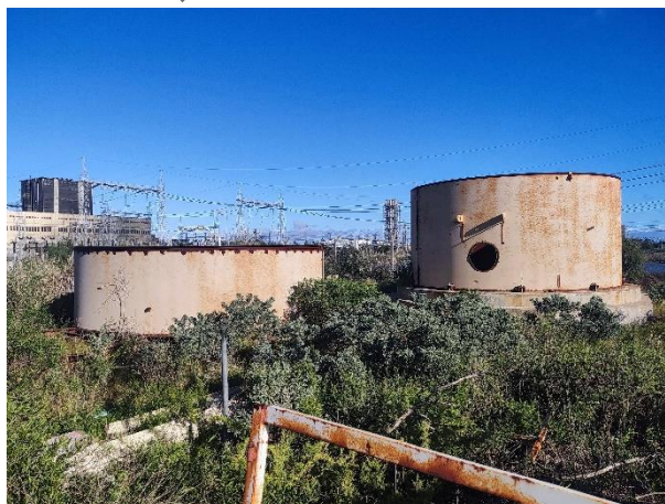
Figura 23. Tanques de agua construidos durante las obras de VALE.
