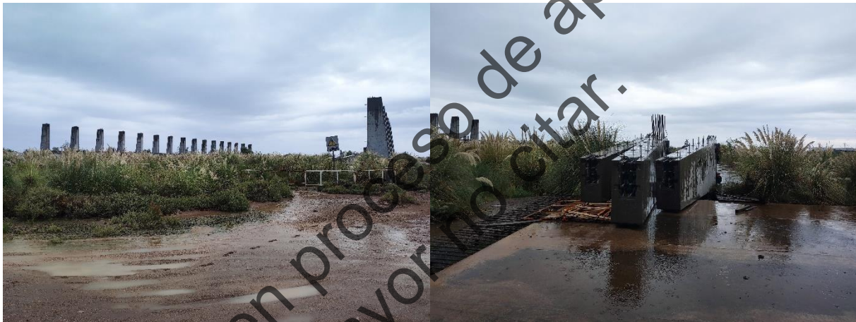
Figura 22. Estructuras civiles construidas durante las obras de VALE.
