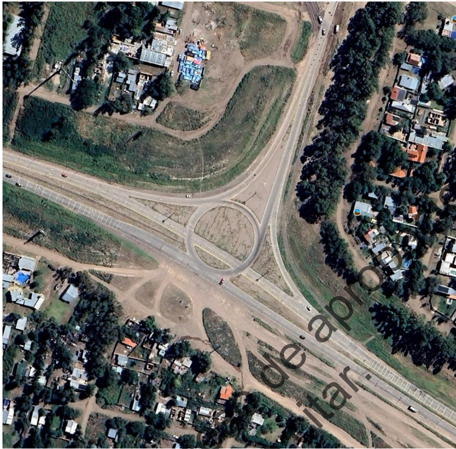
Figura 7. Distribuidor RN3 y RN229. Referencia 2 en la Figura 5.
