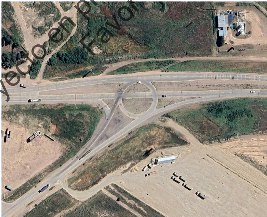
Figura 8. Distribuidor RN3 y RN1. Referencia 3 en la Figura 5.
