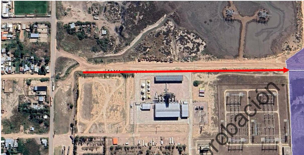
Figura 53. Ubicación del camino de acceso desde RN252.
