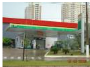
Posto de abastecimento
