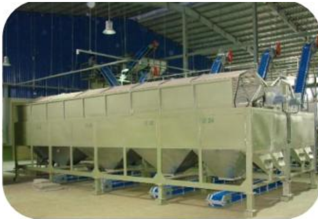
Photo 2 : Zone de vapeur
