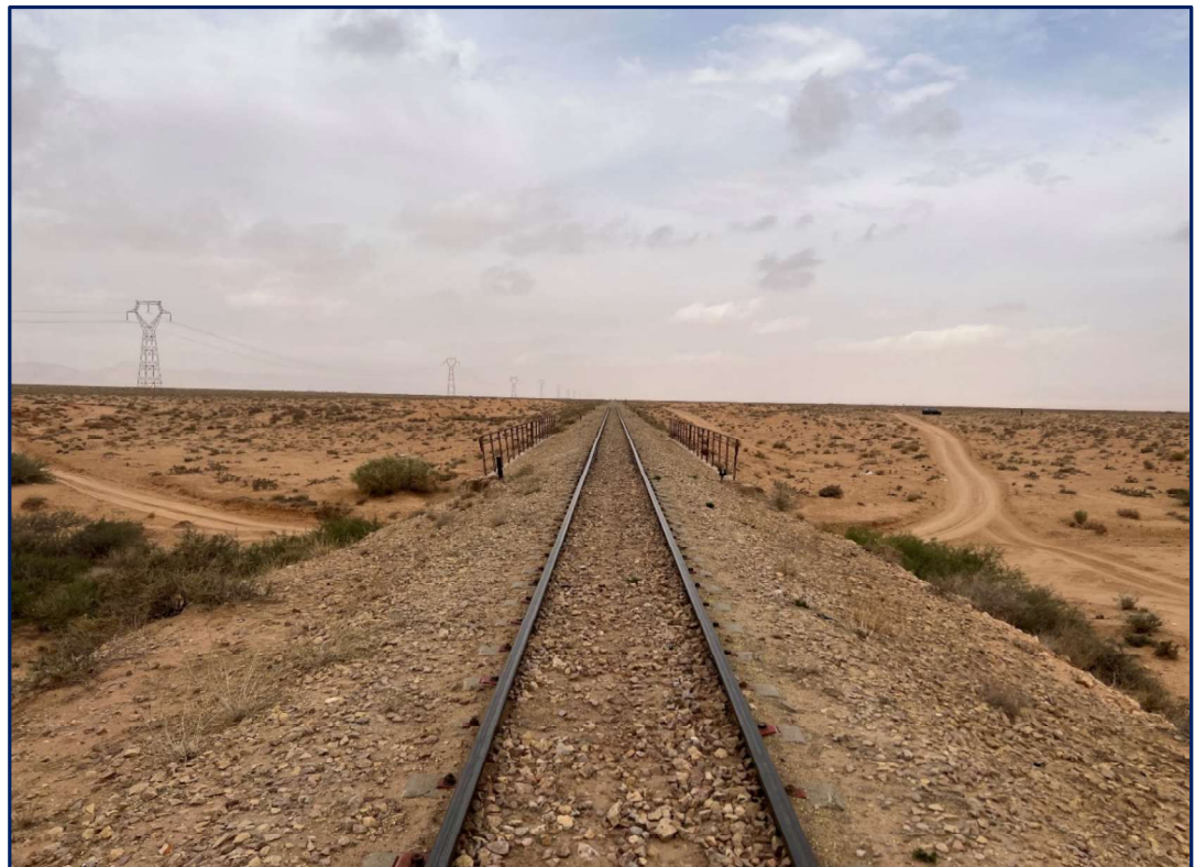
Photo 2 : Chemin de fer traversant le site au niveau d'un pont
