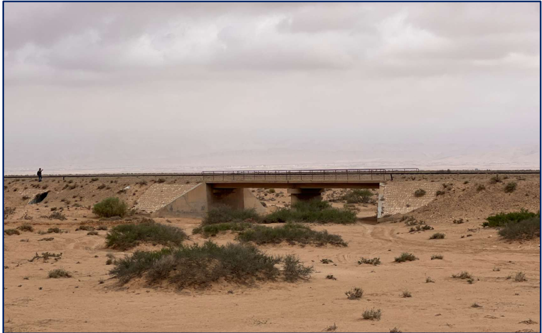
Photo. 5 : Passage d'un Oued sous le pont
