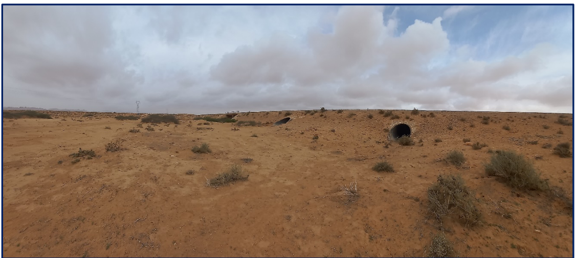
Fig. 5 : Buses et pont de la voie ferrée surplombant le lit d'Oued Mehamla au sud du site destiné au projet du parc solaire Menzel Habib
