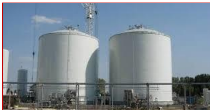
Photo 2-6 : Tank de stockage des masses
