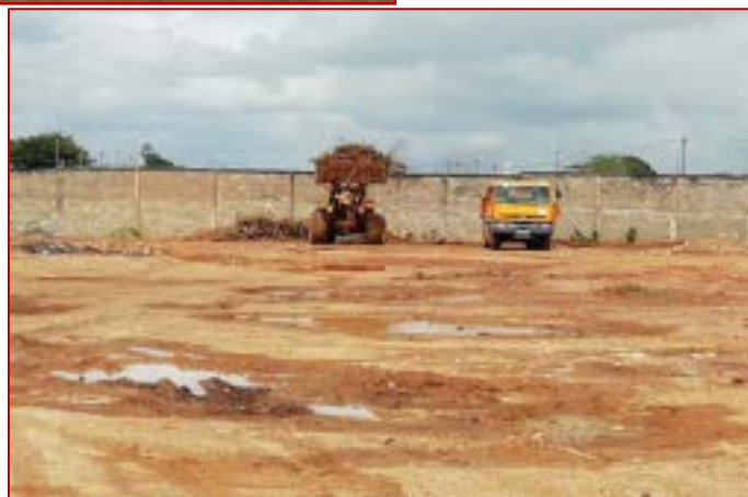
Vue du démantèlement des installations de l'ex Thanry. Septembre 2019
