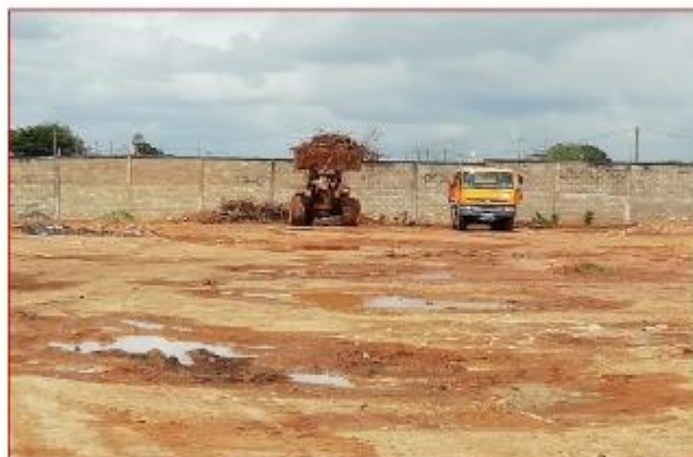
Présence d'engins sur le site du projet
