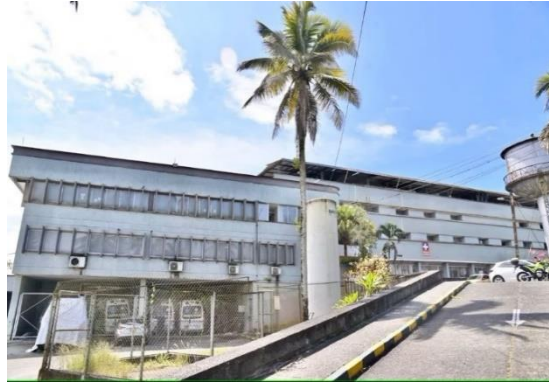
Figura 4.4 Hospital Distrital Luis Ablanque de la Plata
