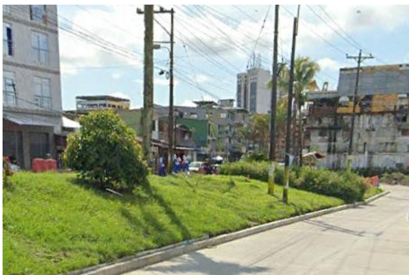
Fotografía 4.9. Separador vial PR 0+800 a PR 1+200
