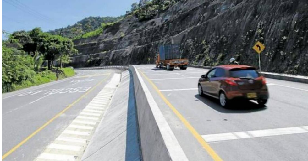
Figura 2.4. Obras de estabilización.
