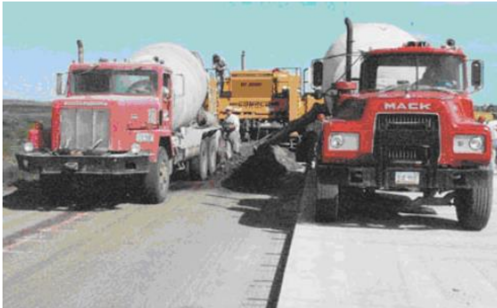
Figura 2.2. Recubrimiento blanco (whitotopping)
