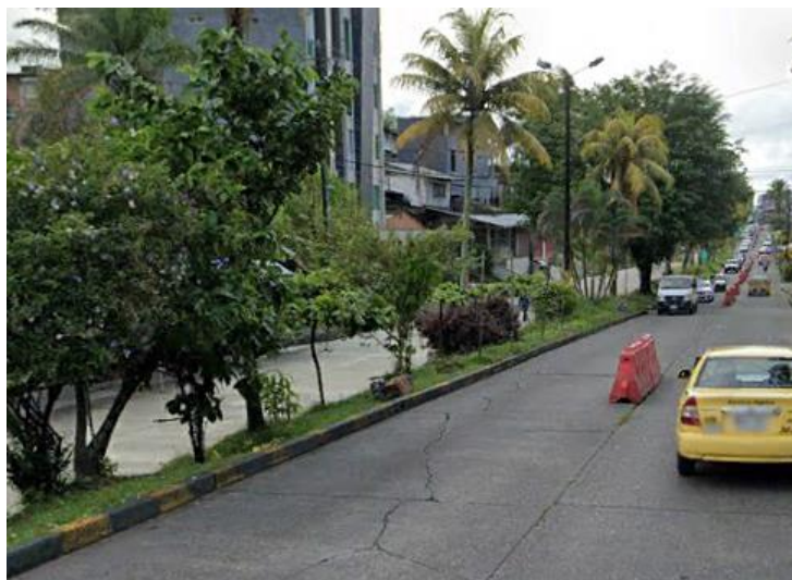
Fotografía 4.10. Separador vial PR 0+180 a PR 1+200 Fuente: Google earth, 2023.
