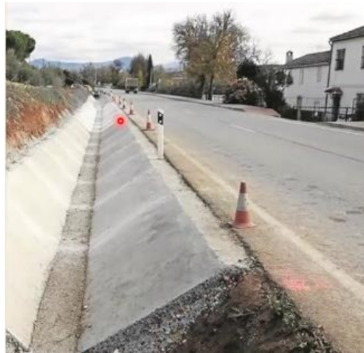
Figura 2.3. Construcción y rehabilitación de obras de drenaje
