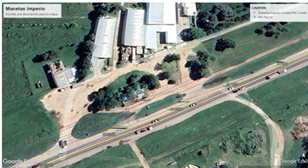
Ilustración 18: Duplicación de calzada ruta A005, afectación sobre puesto Macetas Imperio.
