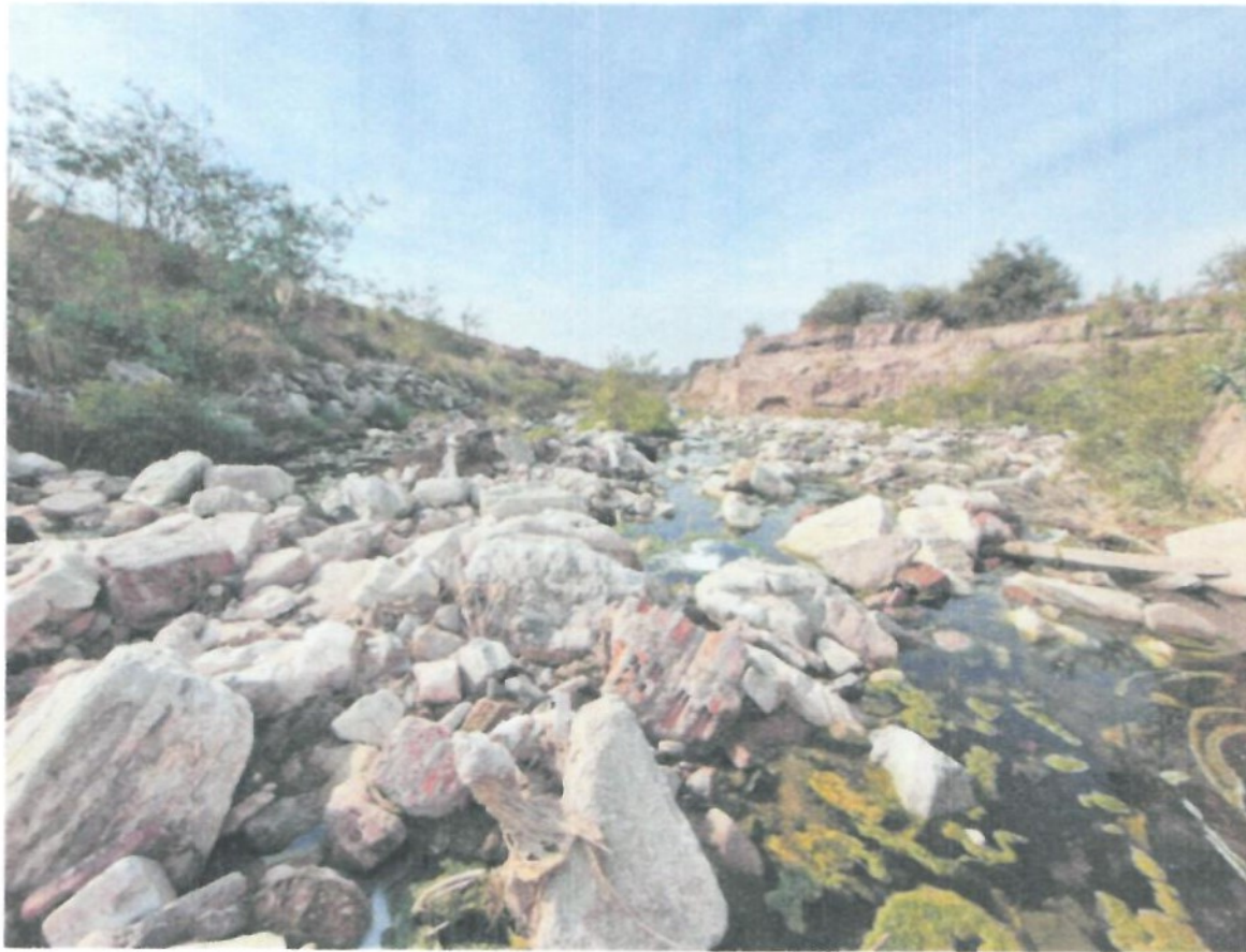
Figura 21: Imagen del Canal, cerca de la desembocadura al Río Chocancharava- Se observa que continúa el enrocado que otorga rugosidad elevada al canal.
