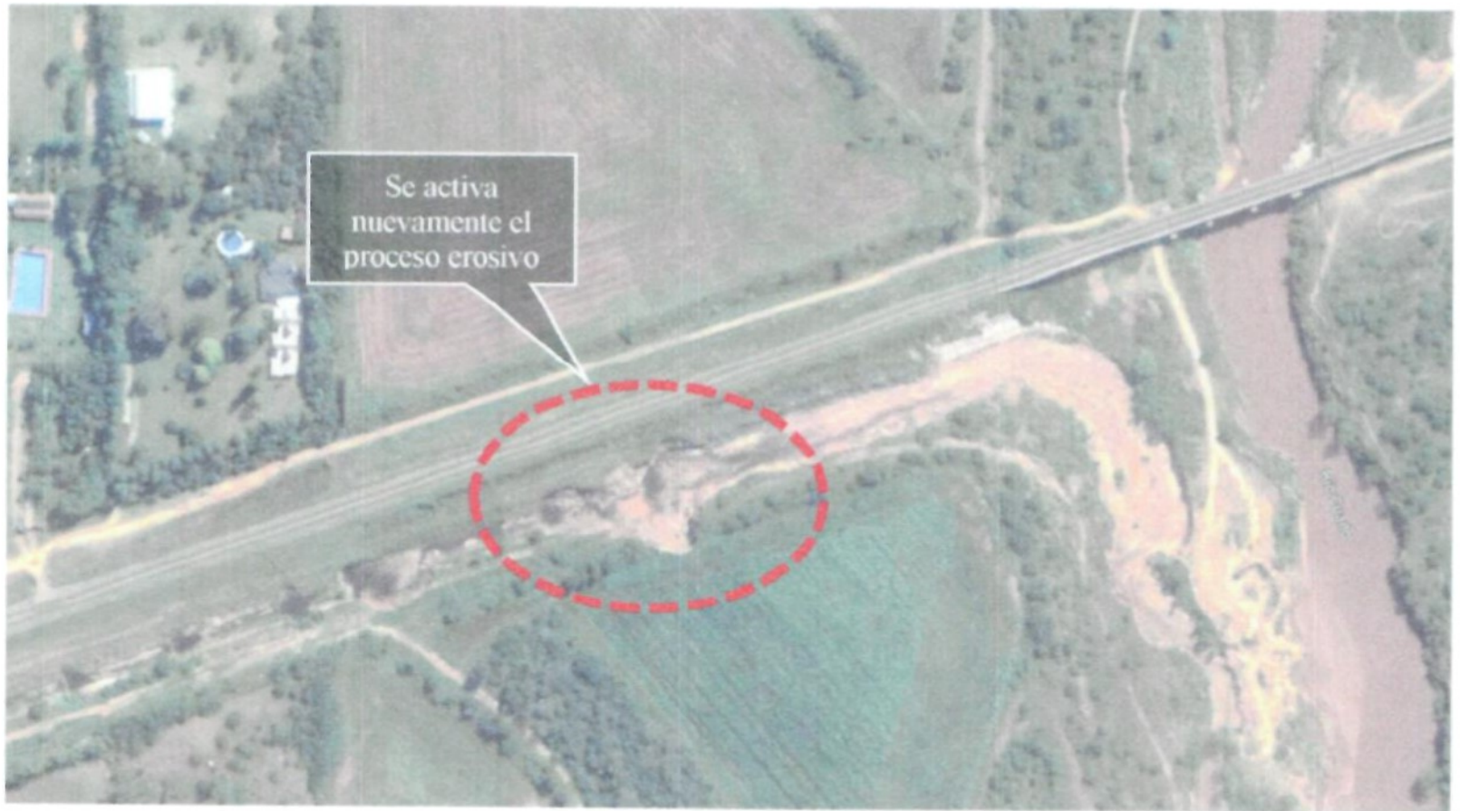
Figura 6: Avance cronológico del proceso de erosión (marzo 2020). La erosión se reactiva, comprometiendo la infraestructura del canal.
