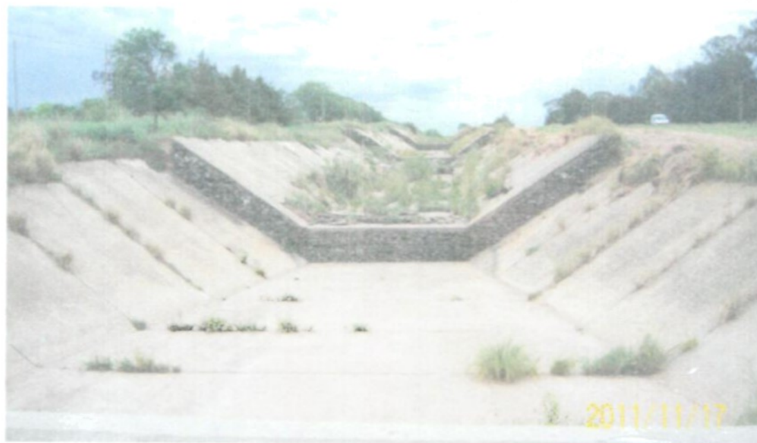
Figura 2: Vista del Canal de desagüe Pluvial en el sector bajo análisis. Recubierto con colchonetas de piedra embolsada, terminada con una carpeta de hormigón.
