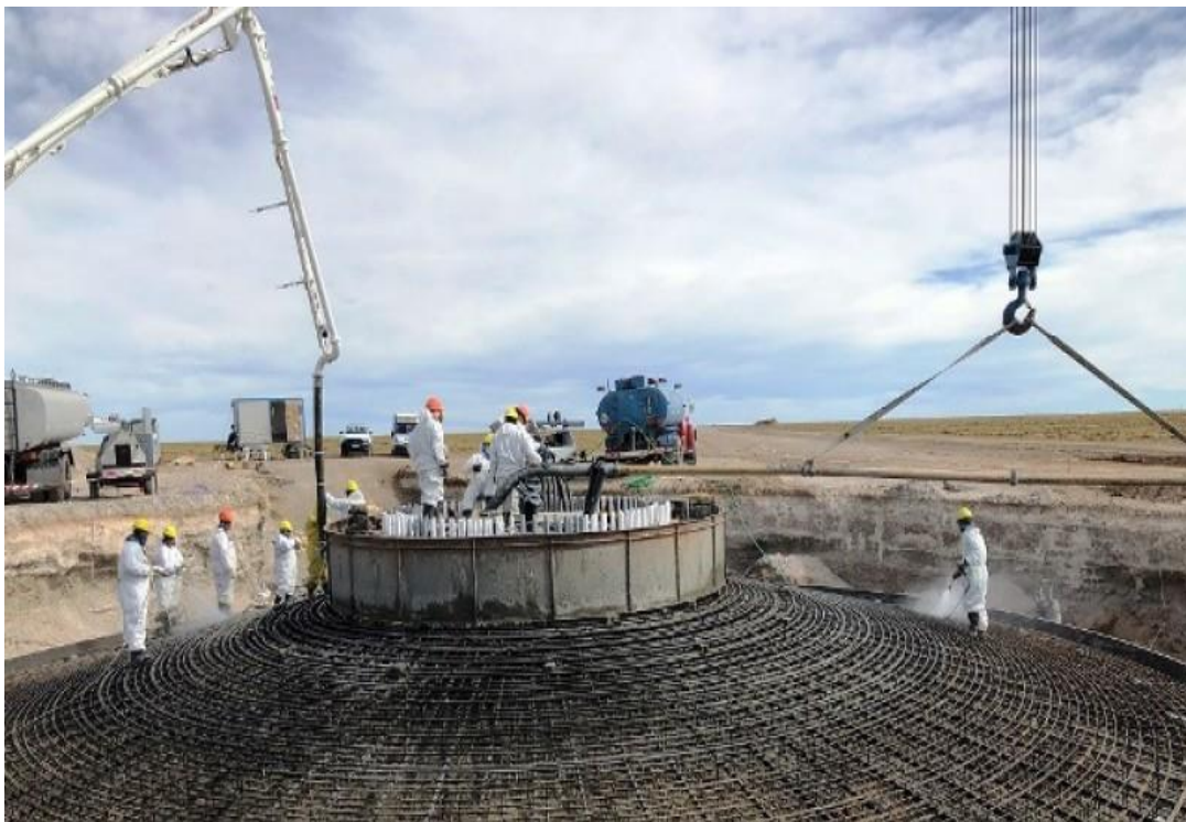
Imagen 20. Tareas de encofrado. Fuente WASA.
