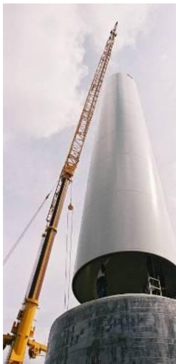
Imagen 22. Montaje de torre. Fuente WASA
