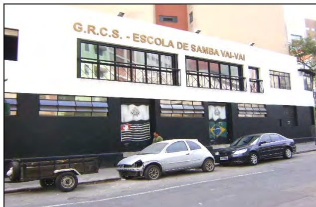
Foto 8.4.12.1-100: Bloco 31 Escola de Samba Vai-Vai. Rua Dr. Lourenço Granato.
