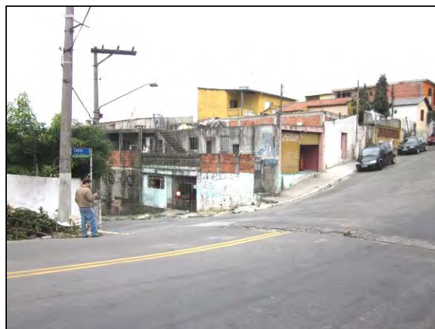
Foto 8.4.12.1-15: Bloco 02D – imóveis residenciais.
