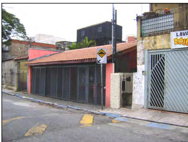
Foto 8.4.12.1-12: Bloco 02C – imóvel em bom estado de conservação. Rua Prof. Viveiros Raposo.
