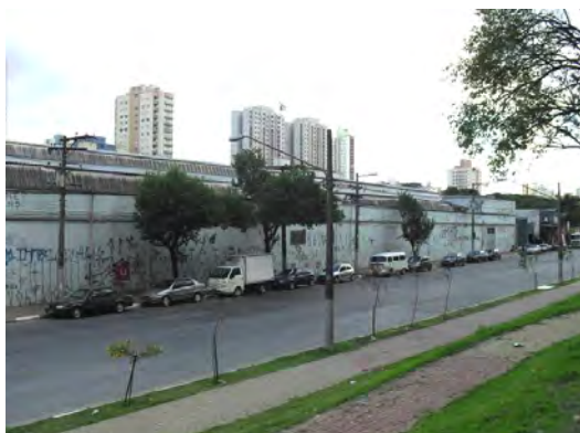
Figuras 8.4.14.4-44: Galpão na Av. Miguel Conejo a ser desapropriado para instalação da Estação Freguesia do Ó
