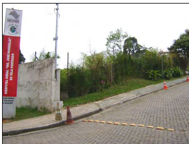
Foto 8.4.12.1-24: Bloco 07 – área desocupada. Avenida Petrólio Portela, ao lado do Hospital Vila Penteado.
