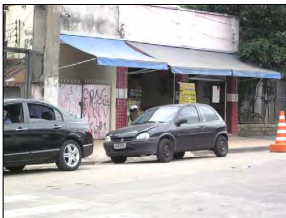
Foto 8.4.12.1-61: Bloco 17B - comercial. Avenida Santa Marina
