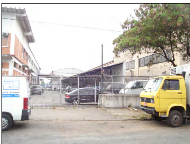
Foto 8.4.12.1-50: Bloco 14 – galpão da funilaria – comercial de padrão médio. Avenida Santa Marina ao sul da Marginal Tietê.
