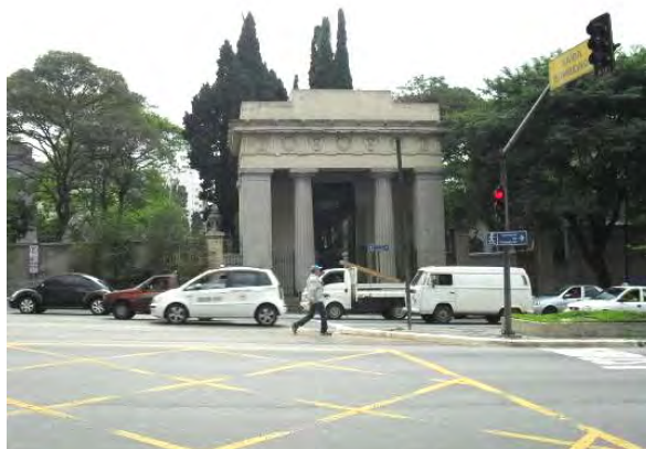
Figuras 8.4.14.4-18: Fachada da entrada principal do Cemitério da Consolação.
