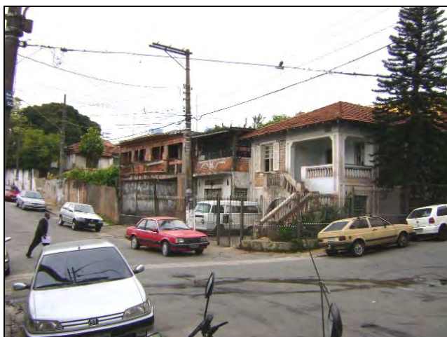
Foto 8.4.12.1-26: Bloco 08A – habitação de padrão médio em mal estado de conservação. Rua Diadema.
