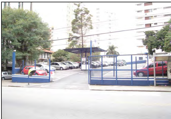
Foto 8.4.12.1-81: Bloco 24B – estacionamento de veículos - ocupação incipiente – localizado no cruzamento das ruas João Ramalho e Cardoso de Almeida.
