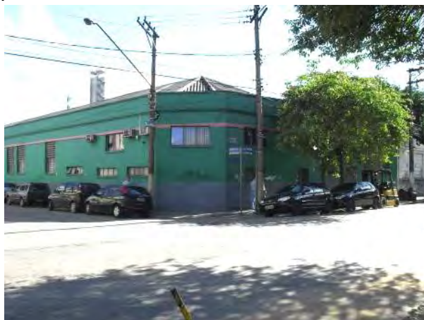
Figuras 8.4.14.4-41: Construção térrea a ser interferida, situada na esquina das ruas Atanásio da Mota e Av. Santa Marina.
