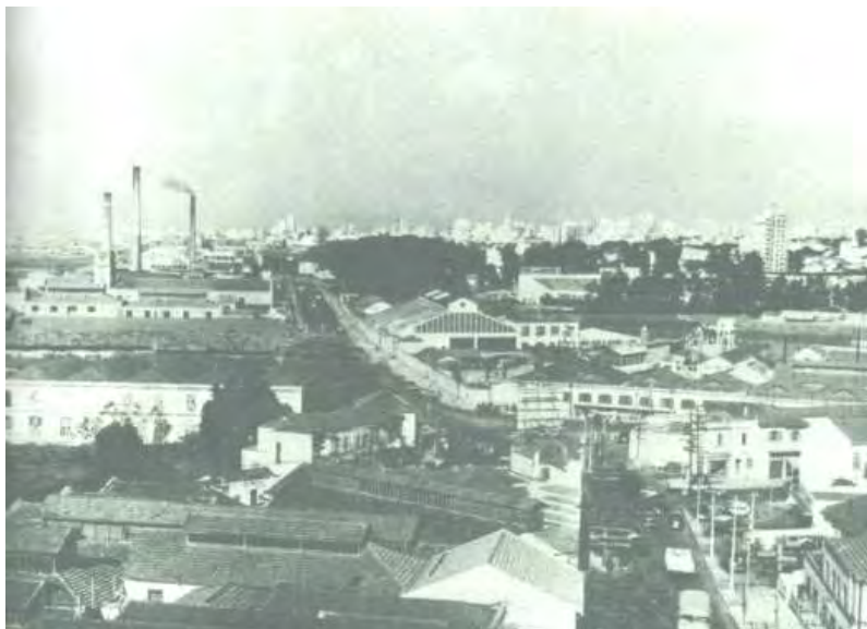
Figura 8.4.14.3-30: Vista geral da Água Branca na década de 1960. Apud. RAMOS, Op.cit., p.133. Na porção esquerda da foto visualiza-se parte da IRFM; à direita a oficina da mesma companhia (atual local do Shopping Bourbon); os viadutos ainda não haviam sido construídos.
