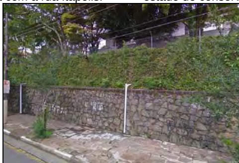
Foto 8.4.12.1-86: Bloco 25A – residencial horizontal em bom estado de conservação. Rua a Itápolis.
