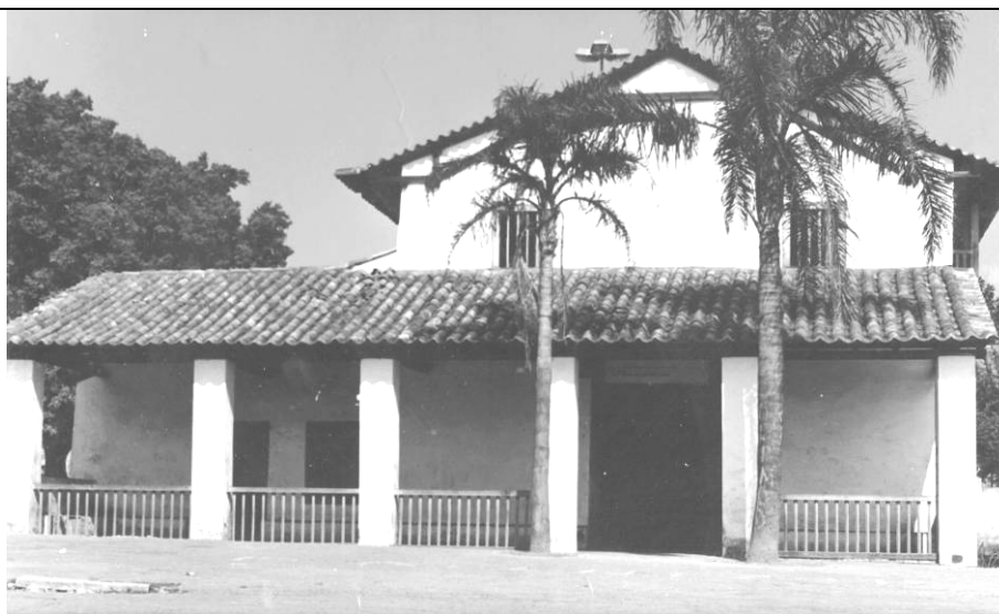
Figura 8.4.14.3-4: Capela de São Miguel, construção colonial jesuítica de 1622, implantado em patamar de média vertente da margem esquerda do rio Tietê.
