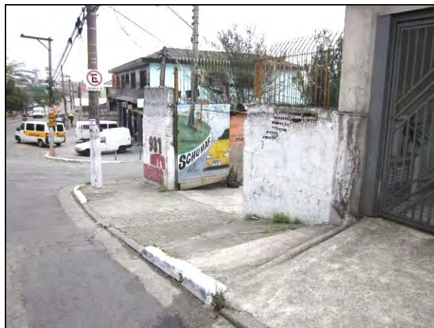
Foto 8.4.12.1-16: Bloco 04 – oficina mecânica
