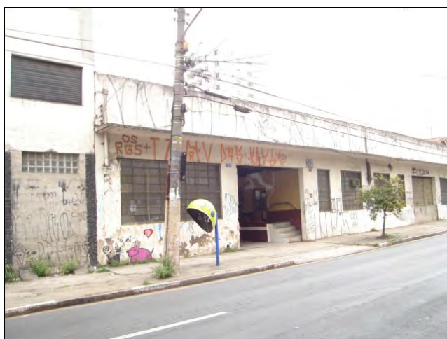
Foto 8.4.12.1-67: Bloco 19A – edificações em estado intermediário de conservação – galpão. Rua Venâncio Aires.
