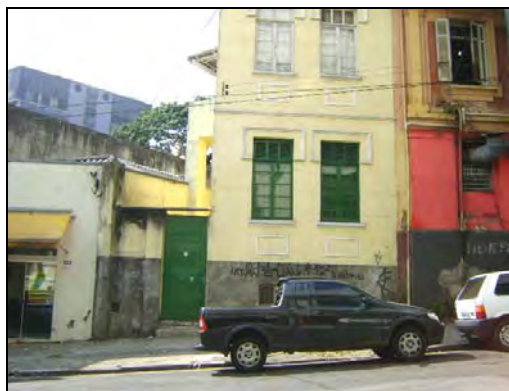
Foto 8.4.12.1-103: Bloco 33B – uso misto. Encontro da avenida Brig. Luiz Antônio com a rua Rui Barbosa.
