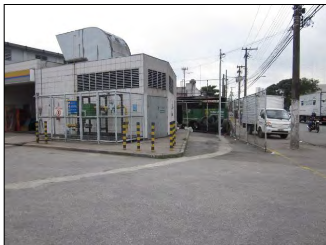
Foto 8.4.12.1-47: Bloco 13 – área de ocupação comercial.
