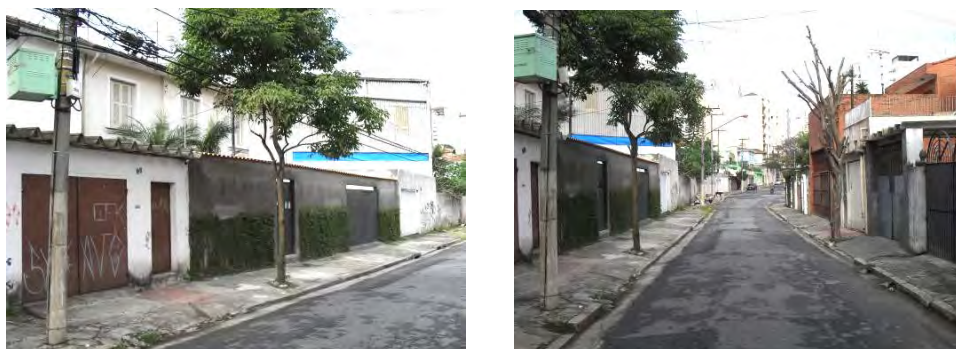
Figuras 8.4.14.4-1: Aspecto das edificações da Rua Senador Felício dos Santos.
