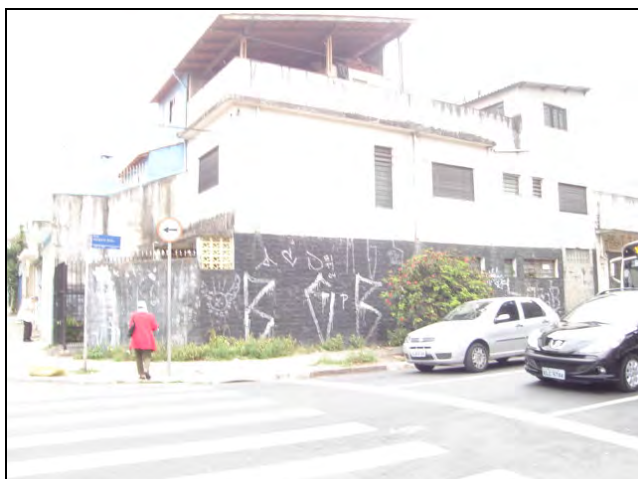
Foto 8.4.12.1-65: Bloco 19A – edificações em estado intermediário de conservação – uso misto de residência e comércio. Rua Venâncio Aires.
