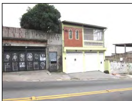
Foto 8.4.12.1-1: Bloco 01 – uso residencial localizado na rua Domingos Vega, prolongamento norte da estrada do Sabão.
