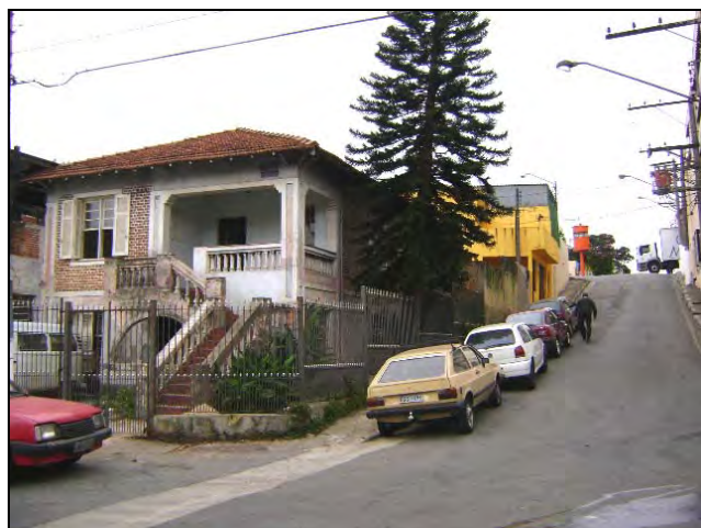
Foto 8.4.12.1-27: Bloco 08A – habitação horizontal de padrão médio. Rua Diadema.
