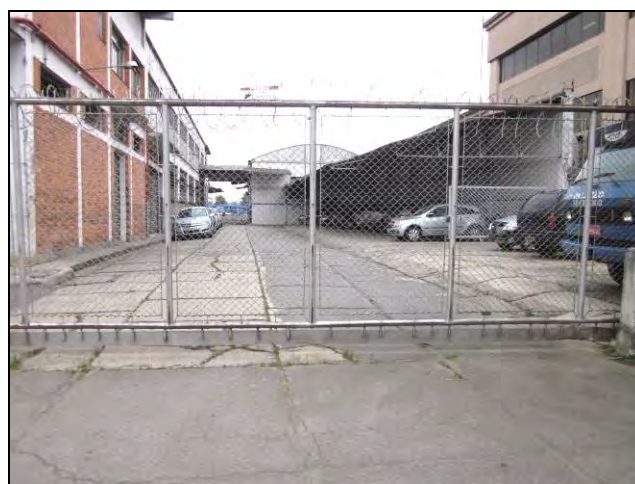
Foto 8.4.12.1-51: Bloco 14 – galpão da funilaria – comercial de padrão médio. Avenida Santa Marina ao sul da Marginal Tietê.
