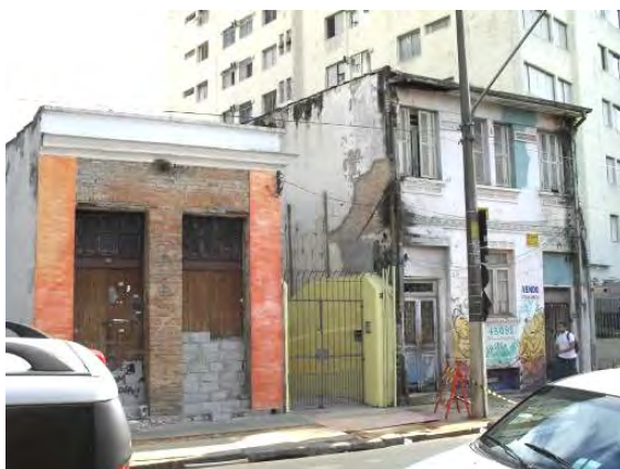
Figuras 8.4.14.4-17: Antigas edificações em meio a Rua Piauí. Exemplo das poucas construções baixas em área de ocupação verticalizada onde está prevista a implantação da Estação.
