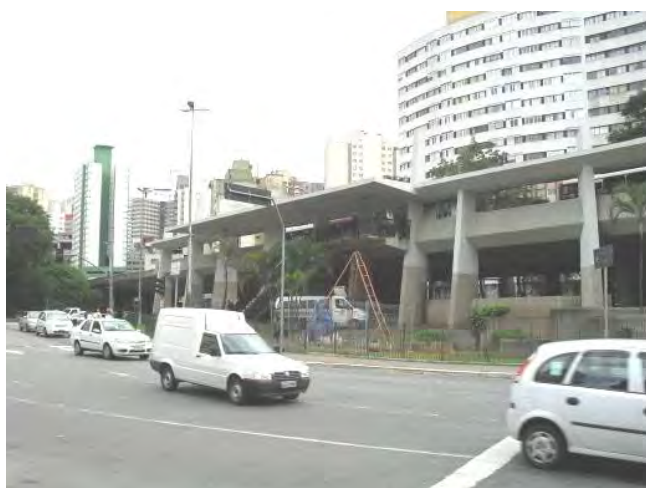
Figuras 8.4.14.4-11: Viaduto da Av. 9 de Julho sobre Praça 14 Bis.
