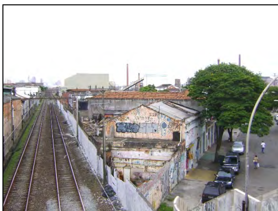
Foto 8.4.12.1-59: Bloco 17A – área de uso misto de comércio e residência.
