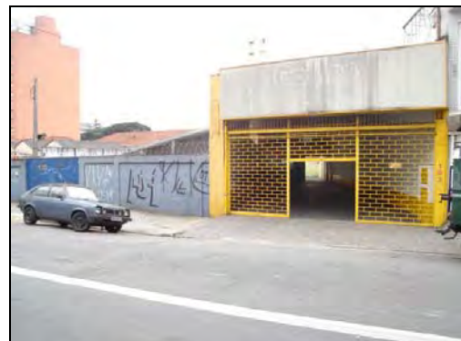
Foto 8.4.12.1-74: Bloco 20 – ocupação incipiente. Rua Venâncio Aires.
