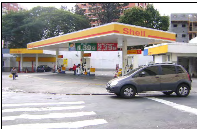
Foto 8.4.12.1-99: Bloco 31 – Posto de combustível na Avenida Nove de Julho.
