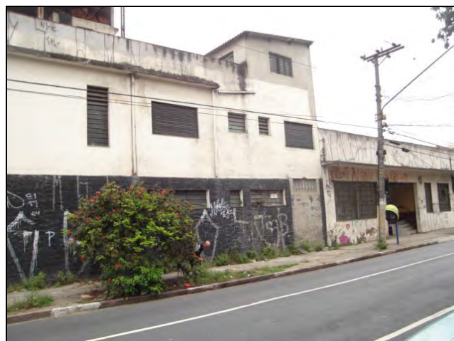
Foto 8.4.12.1-66: Bloco 19A – edificações em estado intermediário de conservação – galpão. Rua Venâncio Aires.
