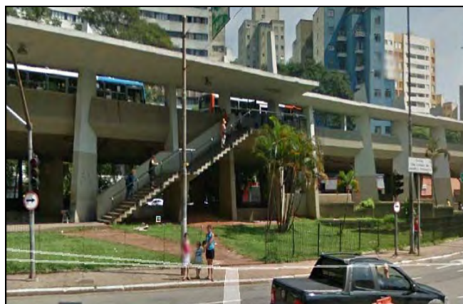
Foto 8.4.12.1-98: Bloco 30B – Praça 14 Bis – área desocupada.
