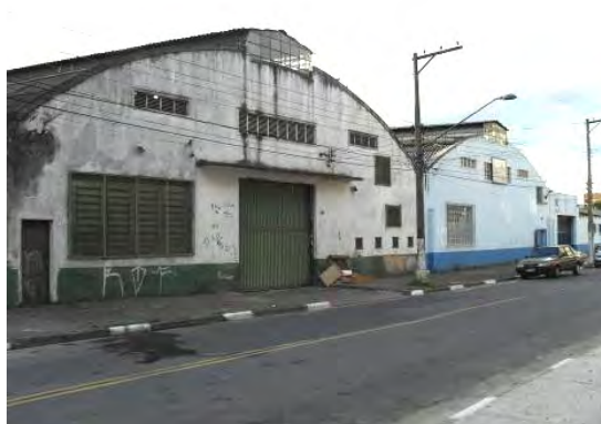
Figuras 8.4.14.4-47: Galpões situados na Rua Simão Velho.
