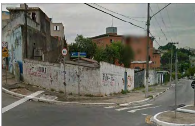
Foto 8.4.12.1-17 – Bloco 05A Residências de médio padrão na esquina da Estrada do Sabão com av. Michihisa Murata.
