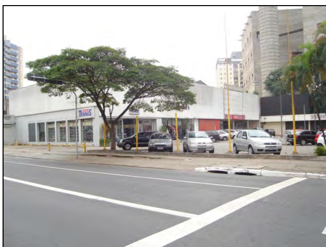
Foto 8.4.12.1-69: Bloco 19A – edificações em estado intermediário de conservação – comércio (lojistas). Rua Venâncio Aires com a avenida Pompéia.
