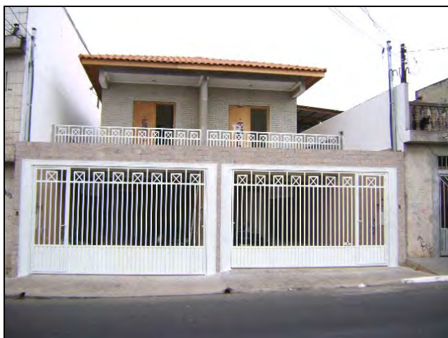
Foto 8.4.12.1-14: Bloco 02C – imóvel residencial em fase final de construção. Estrada do Sabão.
