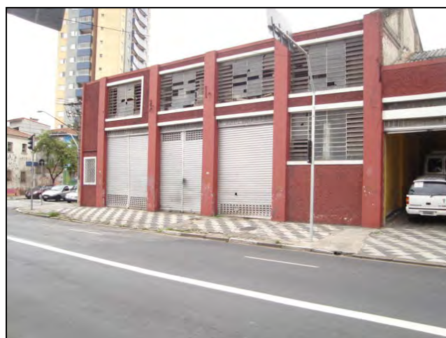
Foto 8.4.12.1-68: Bloco 19A – edificações em estado intermediário de conservação – galpão. Rua Venâncio Aires.
