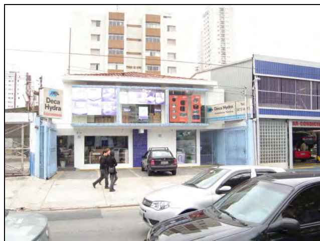
Foto 8.4.12.1-76: Bloco 22 – Loja de produtos hidráulicos, na avenida Sumaré.
