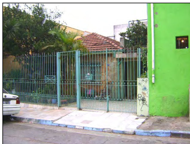
Foto 8.4.12.1-11: Bloco 02C – imóvel em bom estado de conservação. Rua Prof. Viveiros Raposo.
