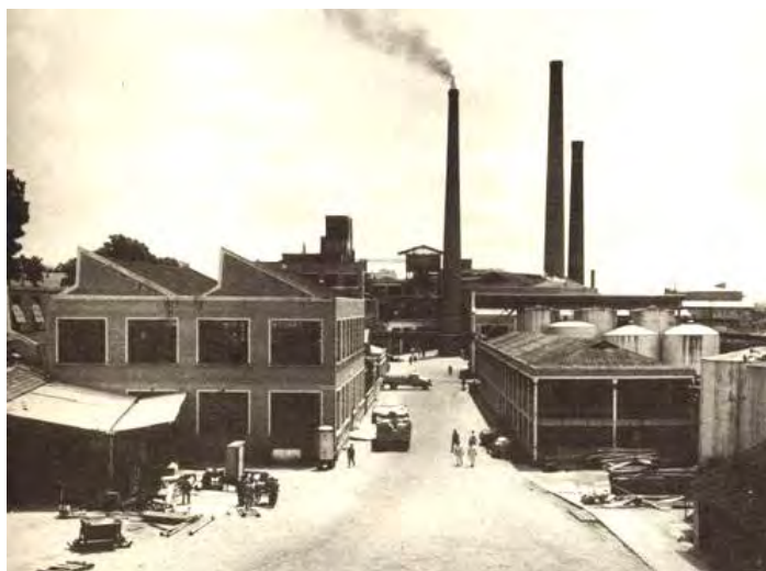
Figura 8.4.14.3-28: Entrada principal do antigo núcleo de fábricas das IRFM da Água Branca. Apud. RAMOS, Op.cit., p.80.
