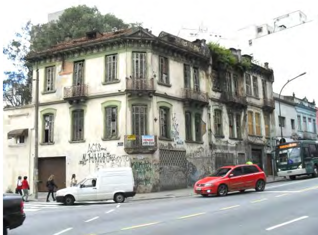
Figuras 8.4.14.4-7: Antigo casarão na esquina da Rua Santa Magdalena com Av. Brigadeiro Luis Antônio.
