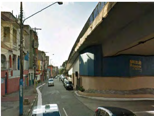
Foto 8.4.12.1-104: Bloco 33A – uso misto. Viaduto Armando Puglisi e rua Treze de Maio.
