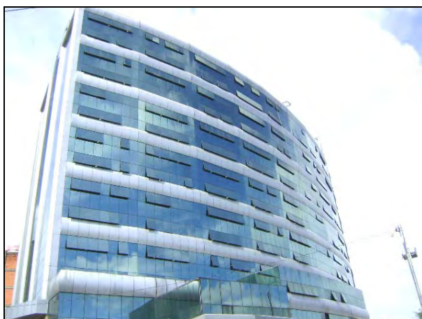
Foto 8.4.11.1-65: UNINOVE – Equipamento social e de serviço localizado na Rua Auro Soares de Moura Andrade – próximo ao terminal Intermodal Barra Funda.
