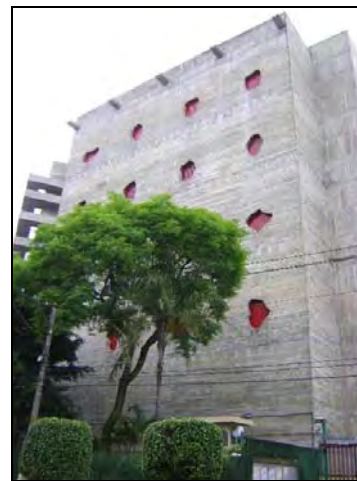
Foto 8.4.11.1-57 : SESC Pompéia, localizado na Rua Clélia, bem próximo da avenida Pompéia.
