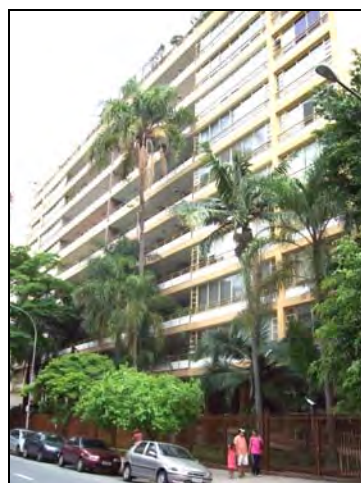
Foto 8.4.11.1-92 – Edifício antigo, localizado na avenida Higienópolis
