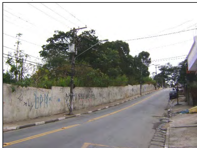
Foto 8.4.11.1-9 – Estrada do Sabão, situada nas proximidades do projetado pátio de estacionamento e manutenção de trens da linha 6-laranja.
