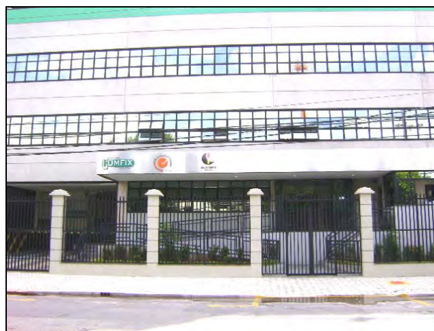
Foto 8.4.11.1-39 - Empresas Confix e Doublé Fastener, localizada na avenida Santa Marina.
