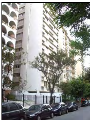
Foto 8.4.11.1-89 – Predomínio de uso residencial vertical no bairro de Higienópolis.
