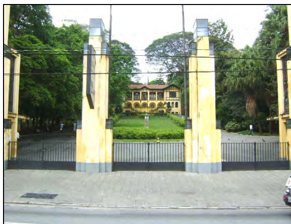
Foto 8.4.11.1-64: Parque da Água Branca – equipamento social e de serviço, localizado na avenida Francisco Matarazzo.
