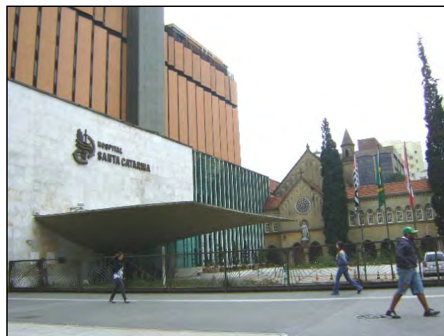
Foto 8.4.11.1-74 – Fachada do Hospital Santa Catarina, localizado na avenida Paulista
