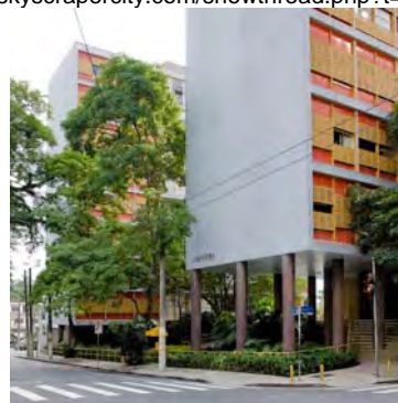
Foto 8.4.8.1-47: Edifício Louveira – praça Vilaboim. ( http://www.skyscrapercity.com/showthread.php?t=763110 )
