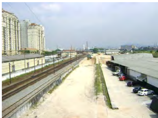
Foto 8.4.8.1-23: Linha férrea – funciona como um limite da ADA – próximo a estação Água Branca.
