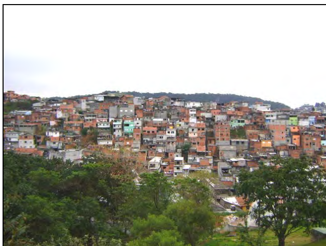
Foto 8.4.11.1-2 – Habitações horizontais e precárias, região norte da área mapeada, situadas próximas ao projetado pátio de estacionamento e manutenção de trens da linha 6 – laranja.
