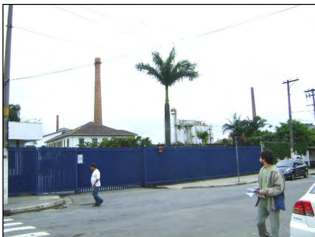
Foto 8.4.11.1-36 - Fachada da Indústria Saint Gobain na avenida Santa Marina.
