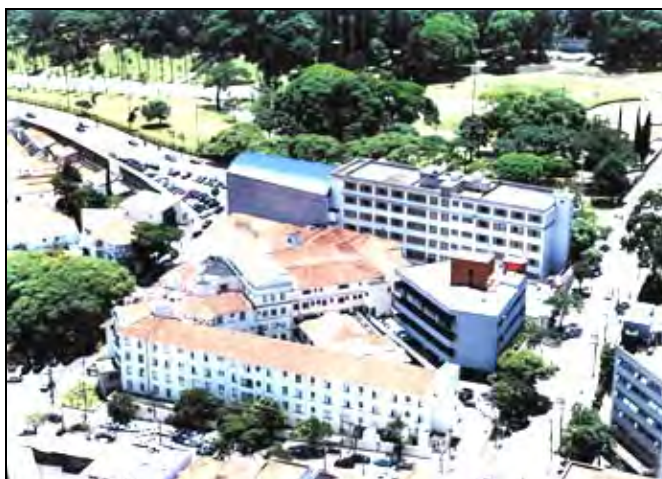
Foto 8.4.11.1-58 – Centro Universitário São Camilo localizado na rua Padre Chico. Fonte: http://www.saocamilosp.br/novo/contato/endereco-unidades.php
