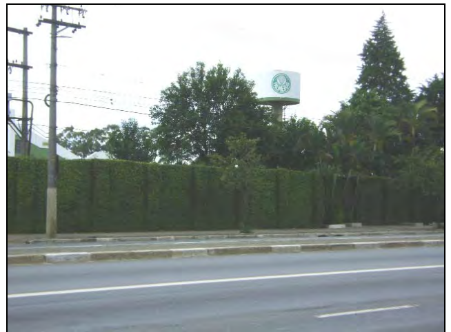
Foto 8.4.11.1-43 – Centro de Treinamento do Palmeiras, localizado na avenida Marquês de São Vicente.
