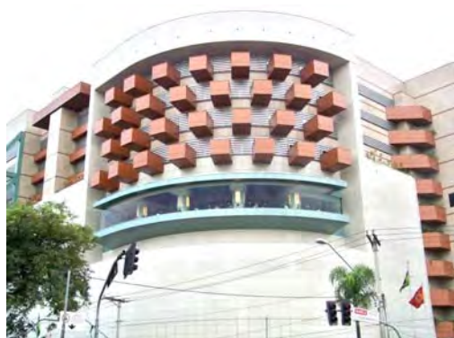
Foto 8.4.8.1-31: Elementos que compõem a paisagem da ADA – Bourbon shopping – próximo estação Pompeia. ( http://www.skyscrapercity.com/showthread.php?t=832776 )
