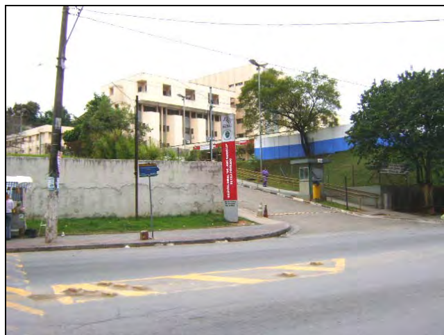
Foto 8.4.11.1-26 – Hospital Geral Vila Penteado localizado na avenida Ministro Petrônio Portela. Área central da Freguesia do Ó.
