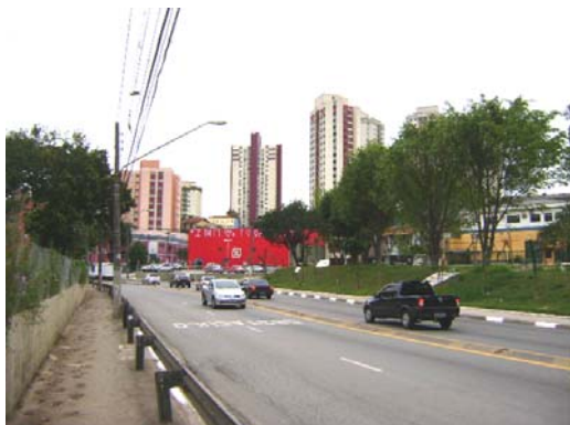
Foto 8.4.9.1-1: Processo de verticalização ao norte da via marginal Tietê.
