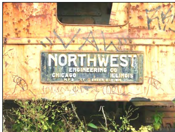
Foto 8.2.9.2-6 – Detalhe de máquina abandonada no local que mostra as condições precárias em que ela se encontra.
