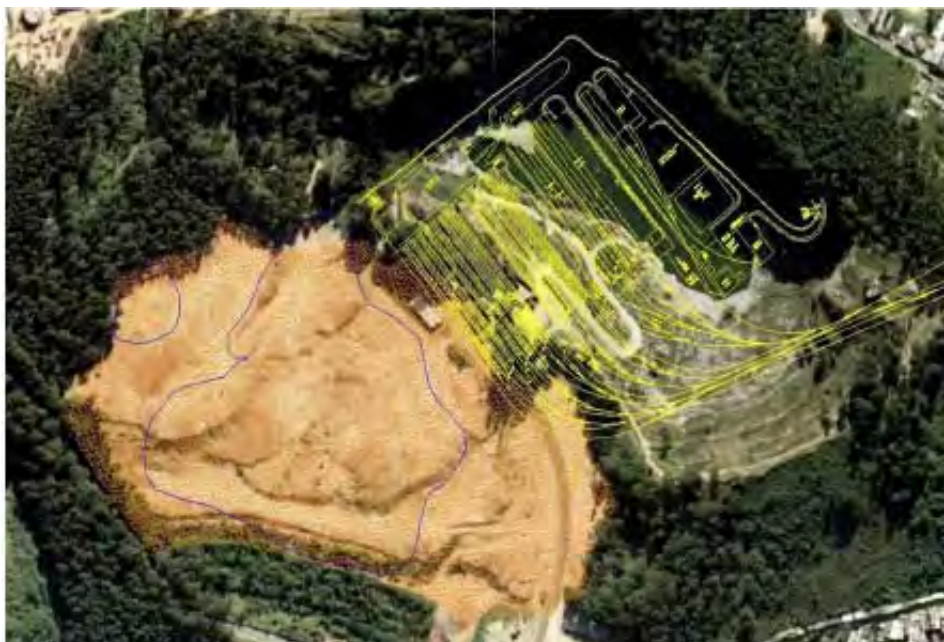
Figura 7.4-2 – Vista geral da área (aterro e cava) da Pedreira Morro Grande e do local projetado para a implantação das estruturas do Pátio da Linha 6
