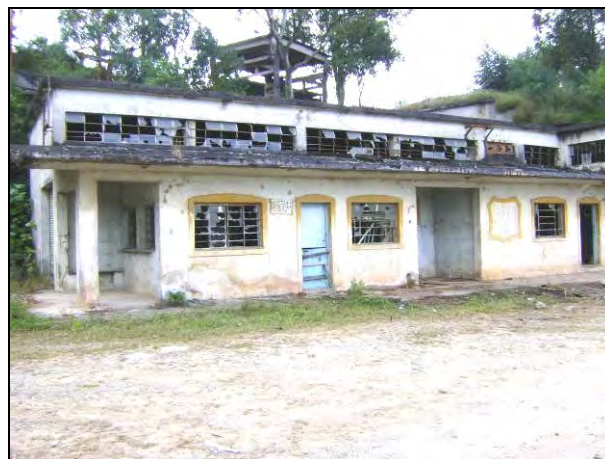
Foto 8.2.9.2-4 – Construção abandonada no terreno da antiga pedreira.
