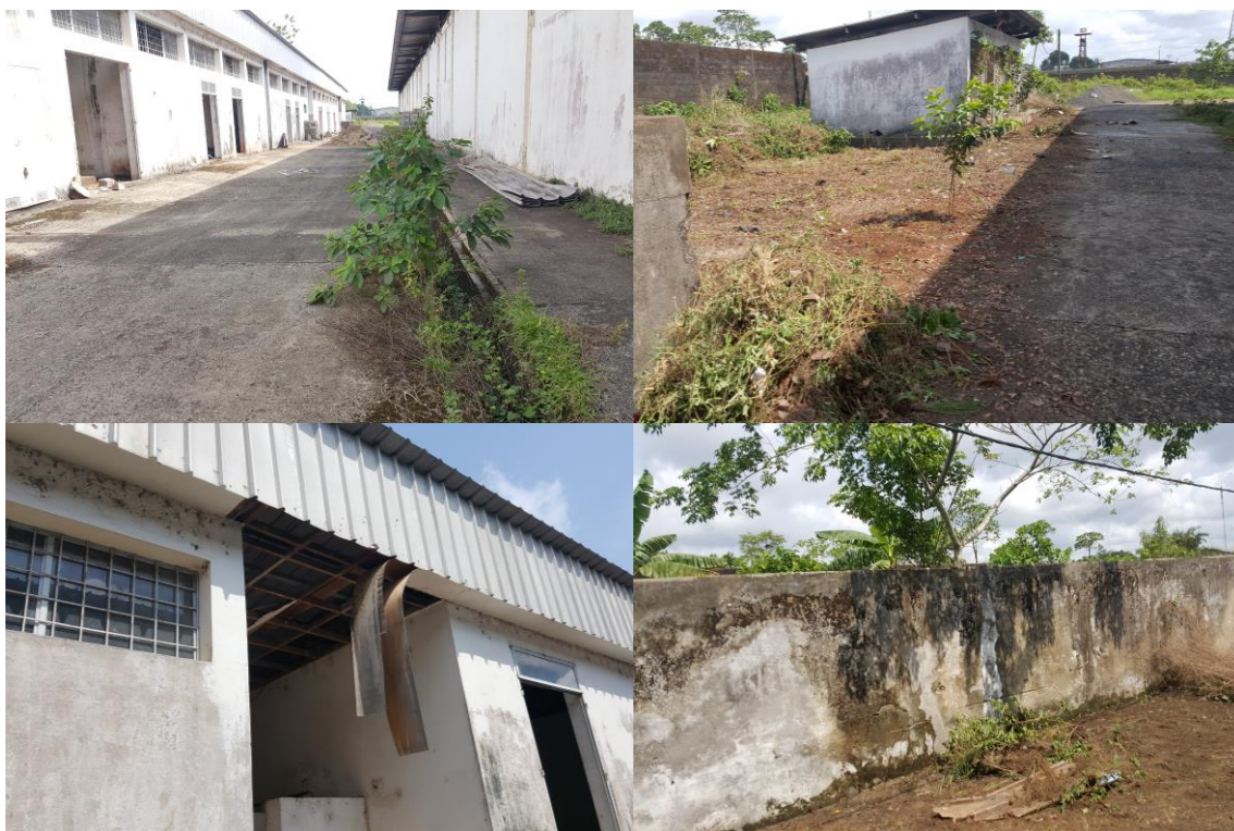
Photo 1 : Quelques vue des installations se trouvant sur le site du projet de EWC
