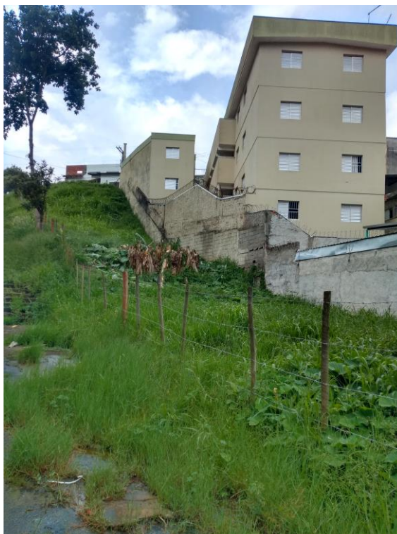
Fotografia 52: Localização da área de estação elevatória
