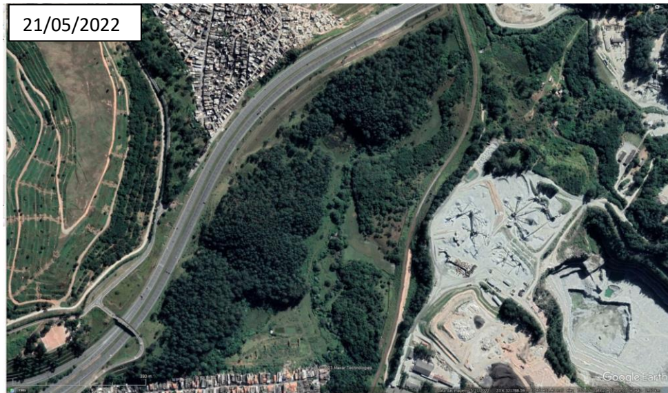
Figura 8 – Imagens aéreas da obra da Prefeitura para combate a enchentes em Perus (período maio/22 a maio/23 – obtido via Google Earth)
