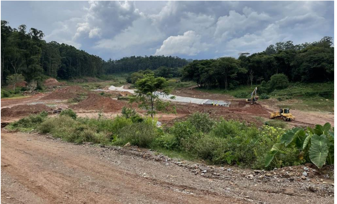
Fotografia 1: Obra da Prefeitura em execução na região de Perus para combate a enchentes
