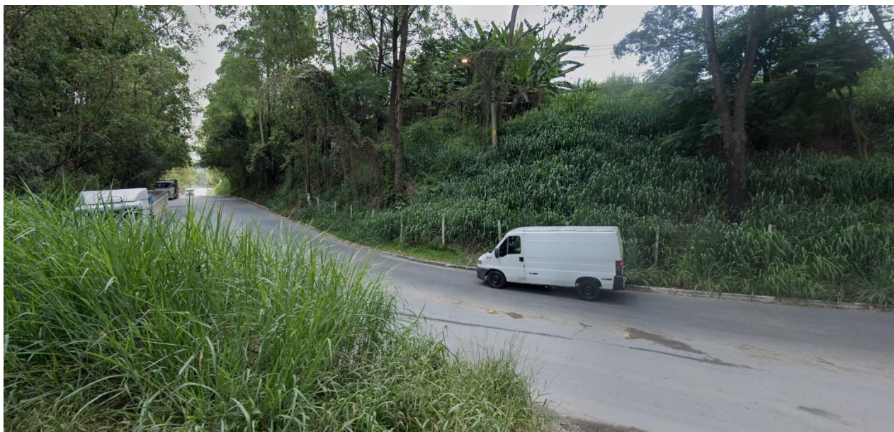
Fotografia 3: Caminhamento do CF Pedreira na Rua Friedrich Von Voith
