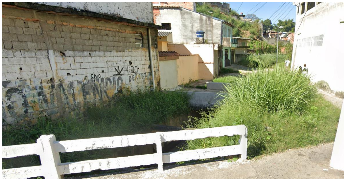
Fotografia 36: O Coletor Tronco Bamburral Jusante passará à margem esquerda do córrego.
