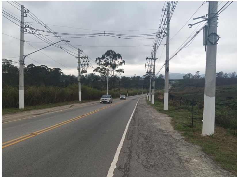
Fotografia 38: Caminhamento do CF Perus 2 – Estrada de Perus
