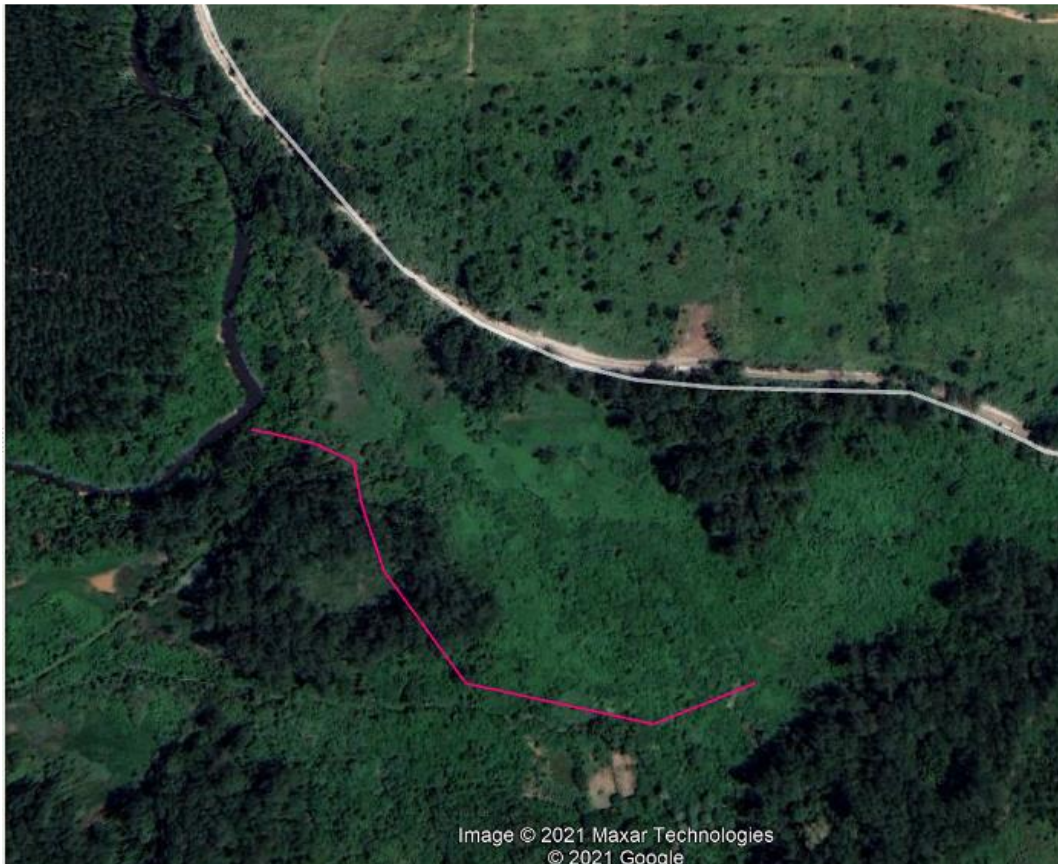
Figura 57: Vista aérea da área do emissário final da futura ETE Perus.
