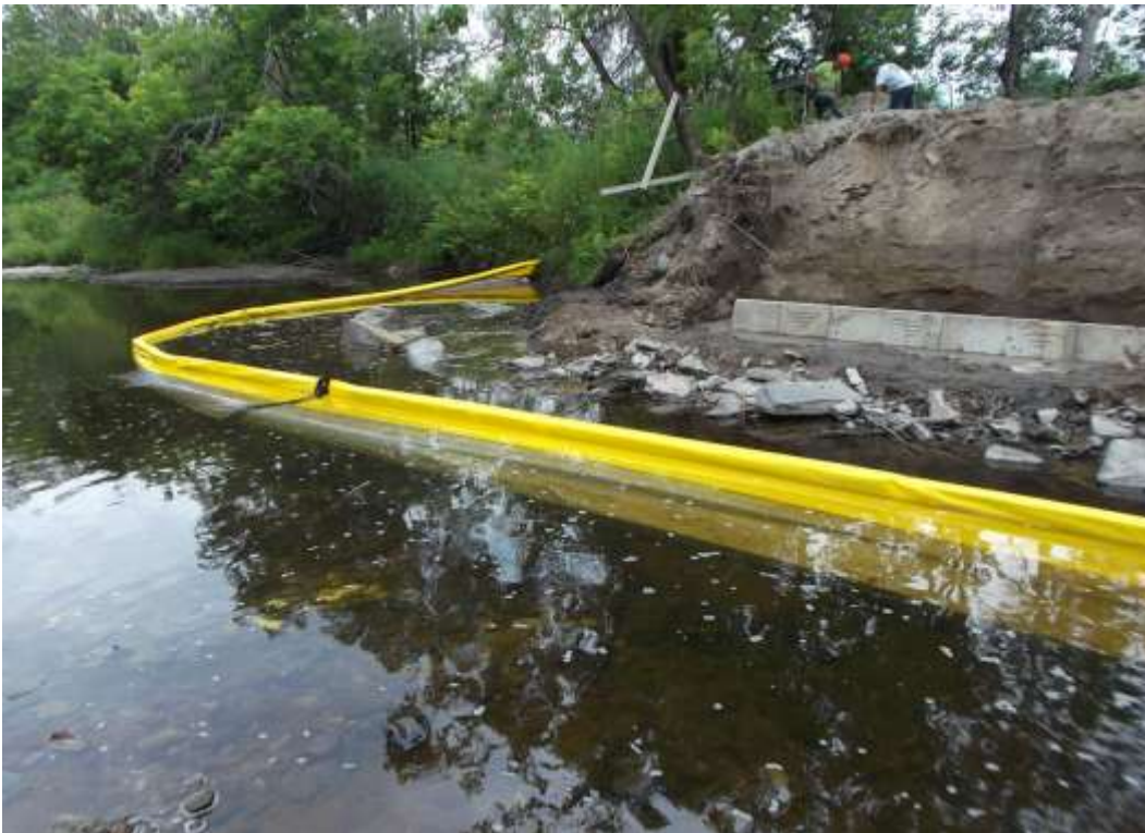
Figure 23 : Exemple de rideau de confinement de turbidité (image en jaune dans la photo)
