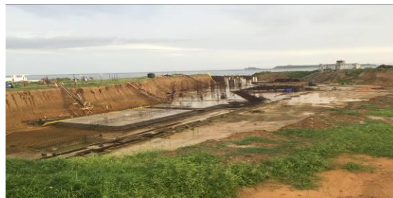
Travaux de fouilles en cours
