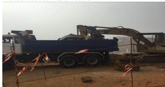
Évacuation des déblais
