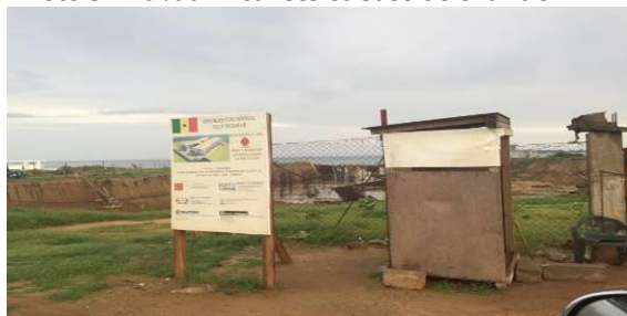
Panneau de signalisation du chantier
