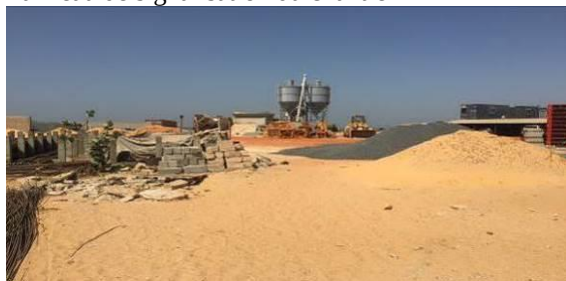
Centrale à béton et stockage de matériaux
