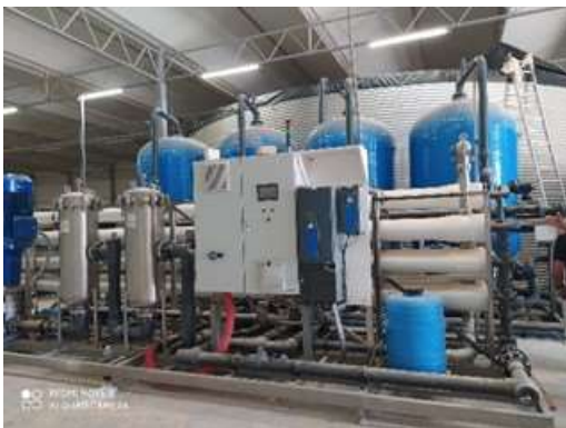
Photo 2: Station de dessalement eau saumâtre
