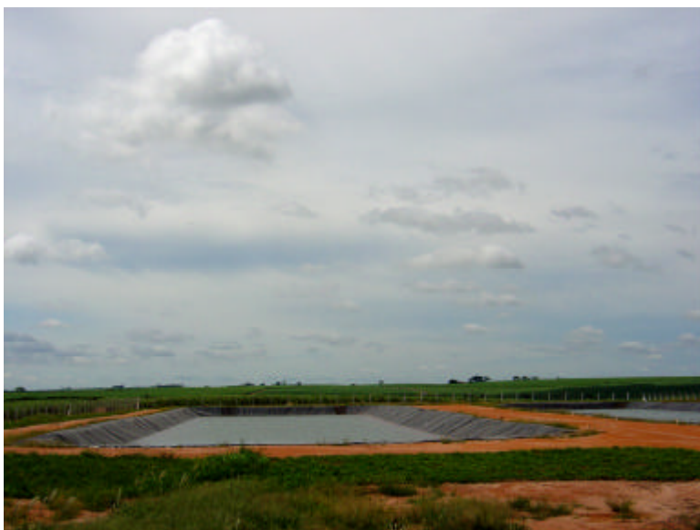
Figura 5.8 – Tanques de vinhaça impermeabilizados.
