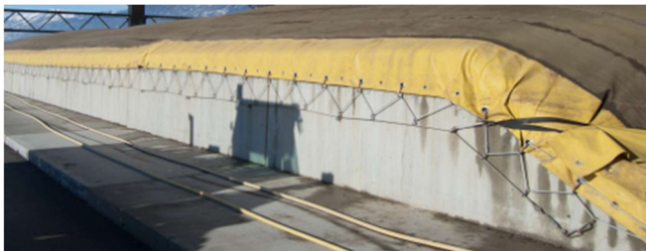
Rysunek 30 Mocowanie membrany za pomocą ściągę
