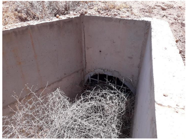
Figure 26: Ouvrage de drainage d'un cours d'eau au sein l'emprise du projet
