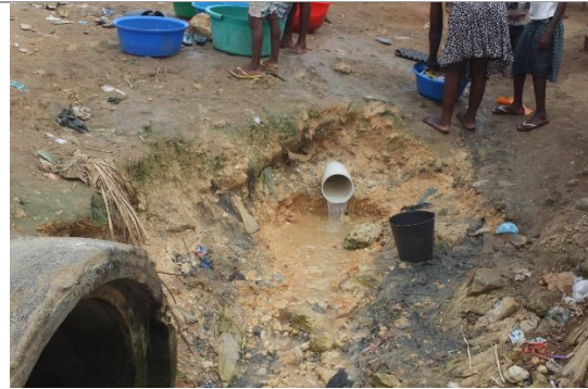
Detalhes da conduta de água potável, ao lado da conduta de efluentes.
