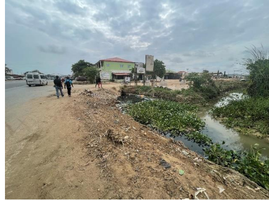
Picada de acesso ao portão do terreno.
