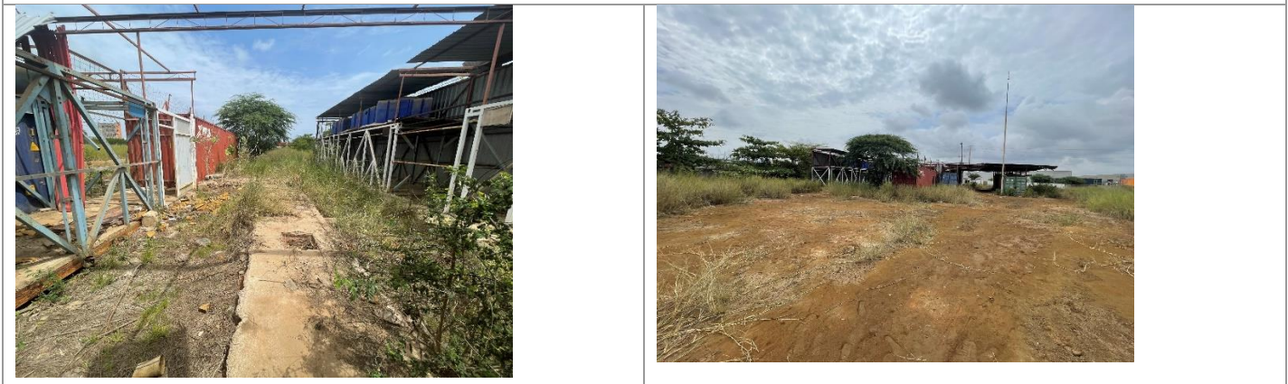
Infra-estruturas no interior do terreno.
