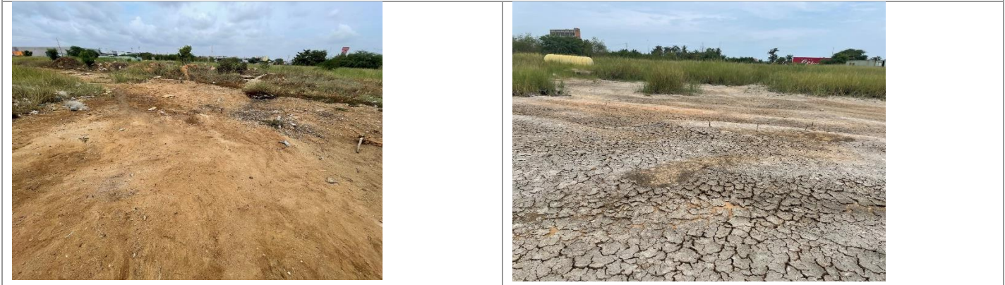
Detalhes do solo do terreno.
