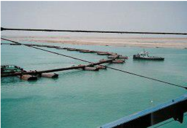
شكل ( 9-2 ) الحفارة ذات الشفط القاطع (CSD) الأنابيب العائمة المستخدمة لنقل المواد المجروفة
