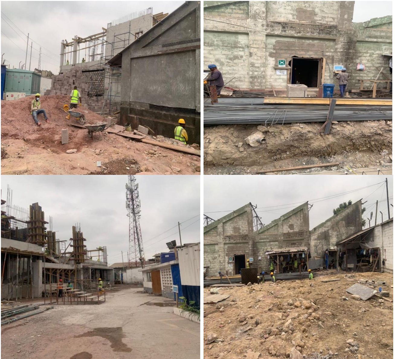
Photo n° 1 : Etat actuel du site en construction
