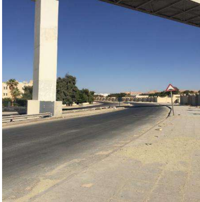
الشكل 186: الطريق الرئيسي في المنطقة الصناعية حيث يمر خط أنابيب النقل من IPS إلى SWRO
