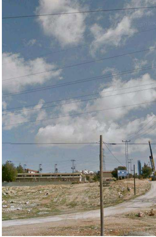
الشكل 239: خزان المنتزه الحالي
