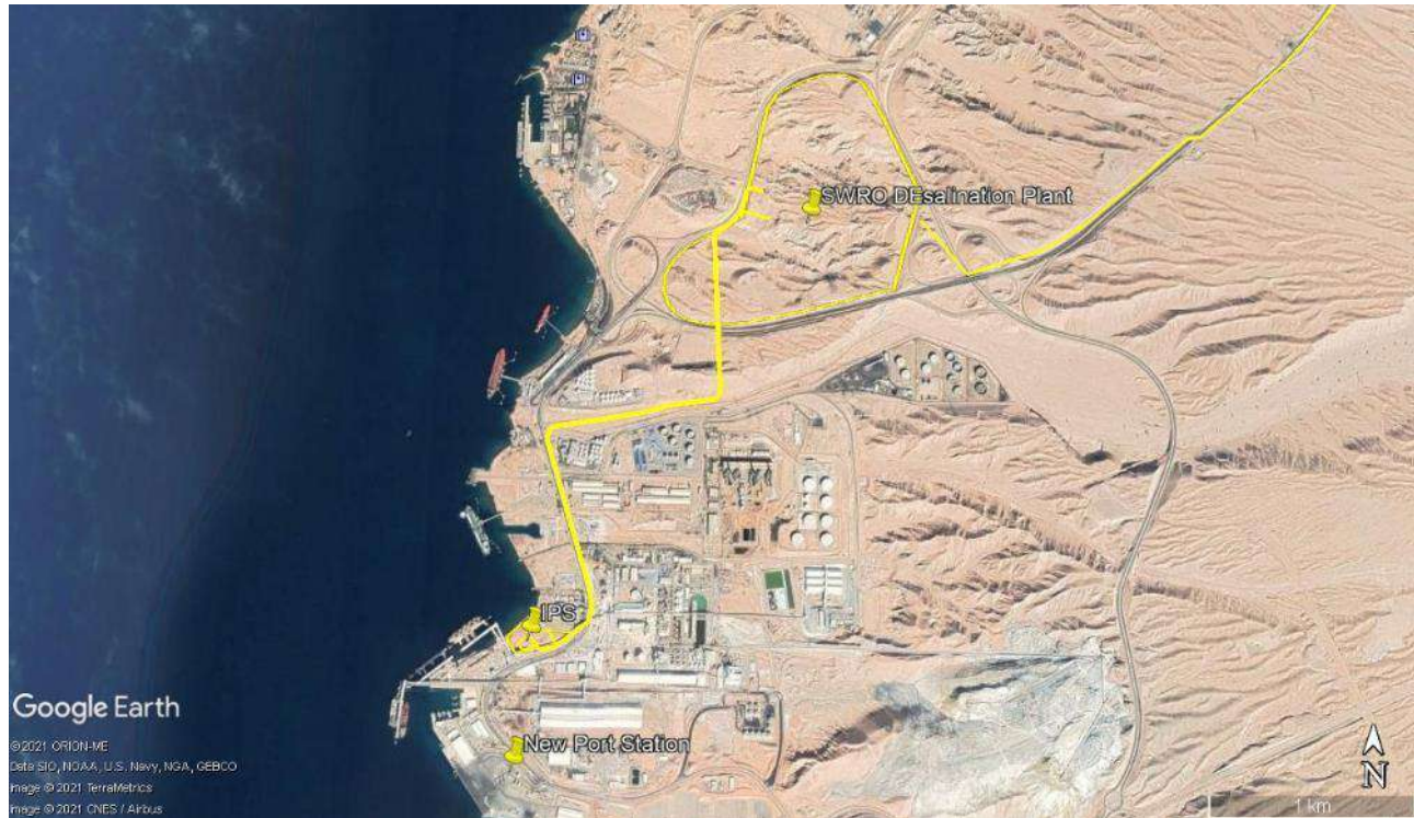
الشكل 62: موقع محطة جودة الهواء في الميناء الجديد، بما فيها محطة سحب وضخ مياه البحر (IPS) ومحطة تحلية المياه بالتناضح العكسي SWRO
