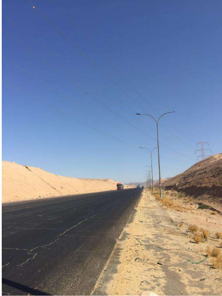
الشكل 191: الطريق من محطة التناضح العكسي RO إلى محطة تقوية الضخ BPS2
