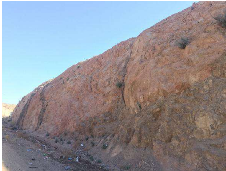
الشكل 196: موقع محطة تقوية الضخ BPS3
