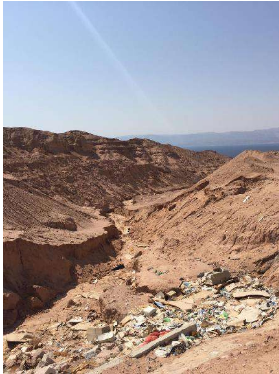
الشكل 189: آثار مجرى المياه في محطة تحلية المياه بالتناضح العكسي SWRO
