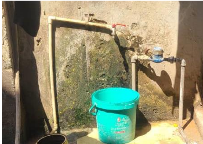
Photo 4. Circuit d'alimentation en eau de la Regideso
