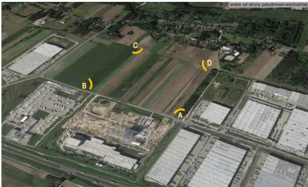
Rysunek 43 Stan aktualny terenu, widok od strony południowo-wschodniej
