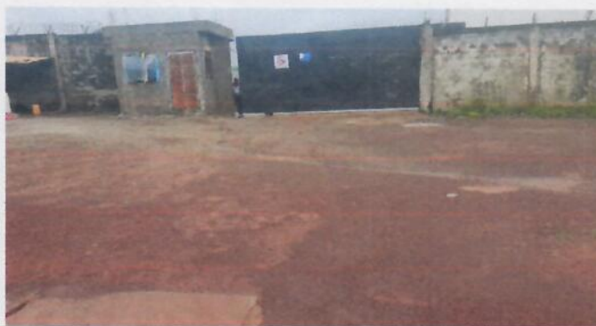
4-Photo de façade du site
