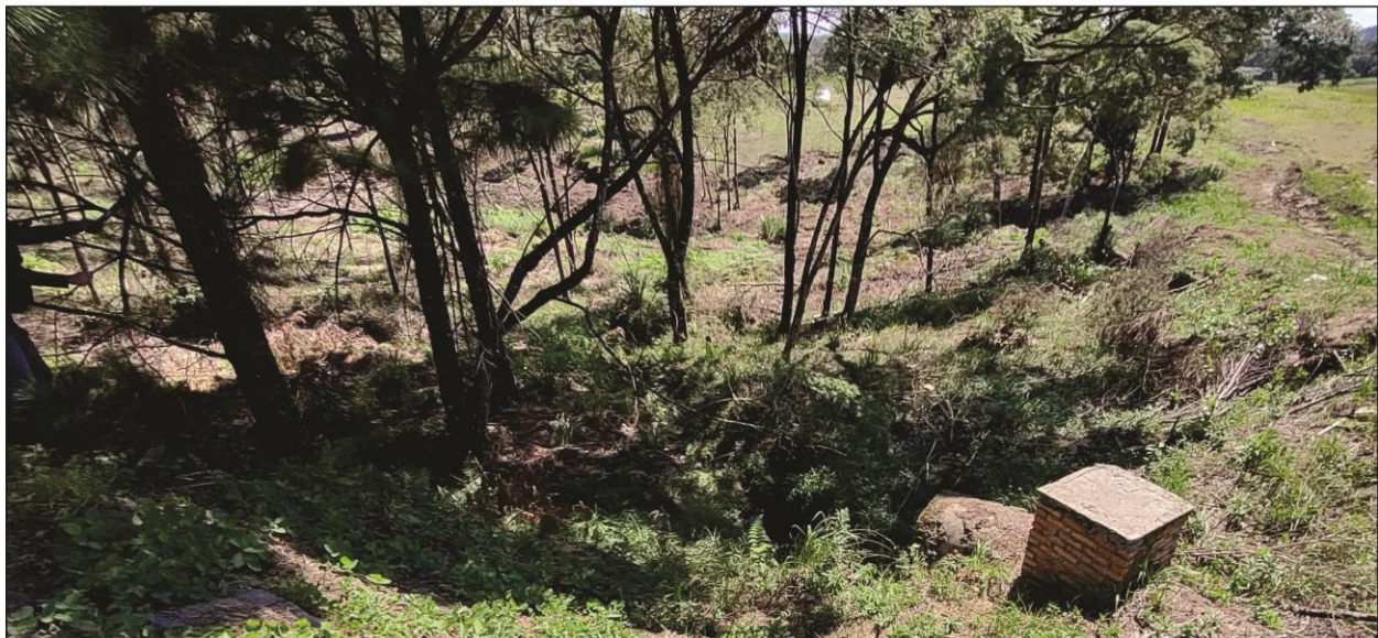
Foto 5. Caixa de passagem e terminal da tubulação de drenagem da área a montante incluindo os telheiros da indústria e da pista de rolamento da Rodovia SC-114.
