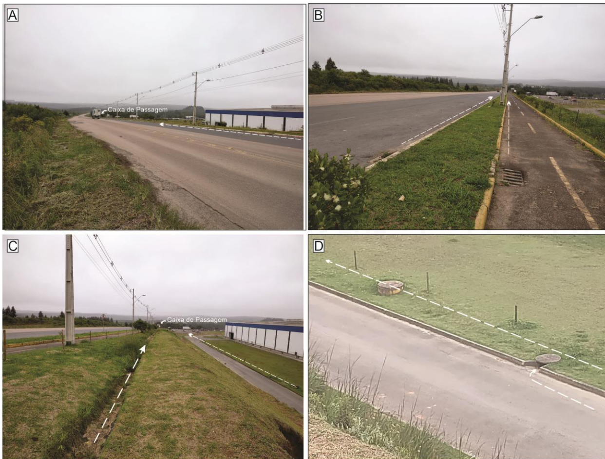
Foto 8. Sistema de captação e drenagem da água pluvial na porção montante que é lançada na área de estudo. A) Eixo da Rodovia SC-114. Notar que no lado direito da pista sentido à BR-280 a drenagem converge para uma caixa de passagem e é lançada na área de estudo. B) Rodovia SC-114 e passarela para pedestres com bocas de lobo e sistema de drenagem que converge para a área da SUDATI e é lançada na área de estudo. C) Lateral da passarela e talude do aterro da rodovia com a SUDATI. Sistema de drenagem converge para a área de estudo. D) Detalhe do sistema de drenagem no pátio da SUDATI que recebe a água pluvial dos telheiros da indústria.
