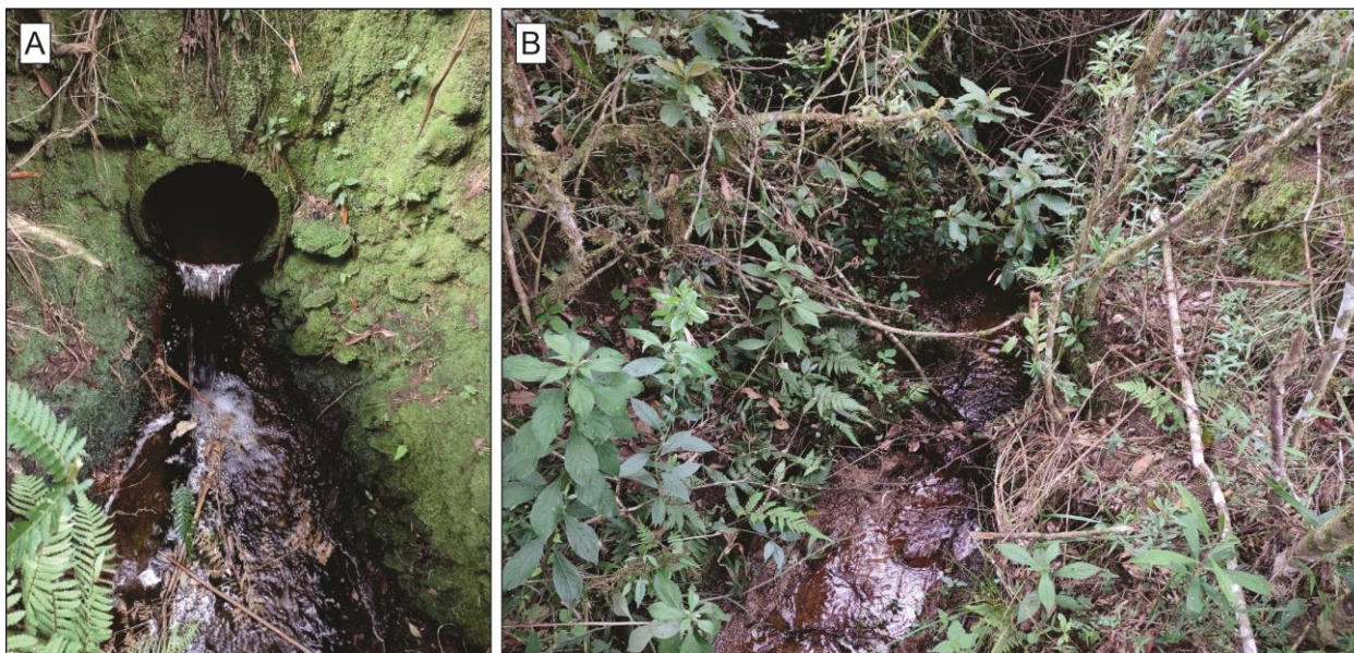
Foto 15. A) Passagem do córrego sob a estrada de acesso aos fundos da área de estudo. B) Sequência do córrego a jusante, a céu aberto.
