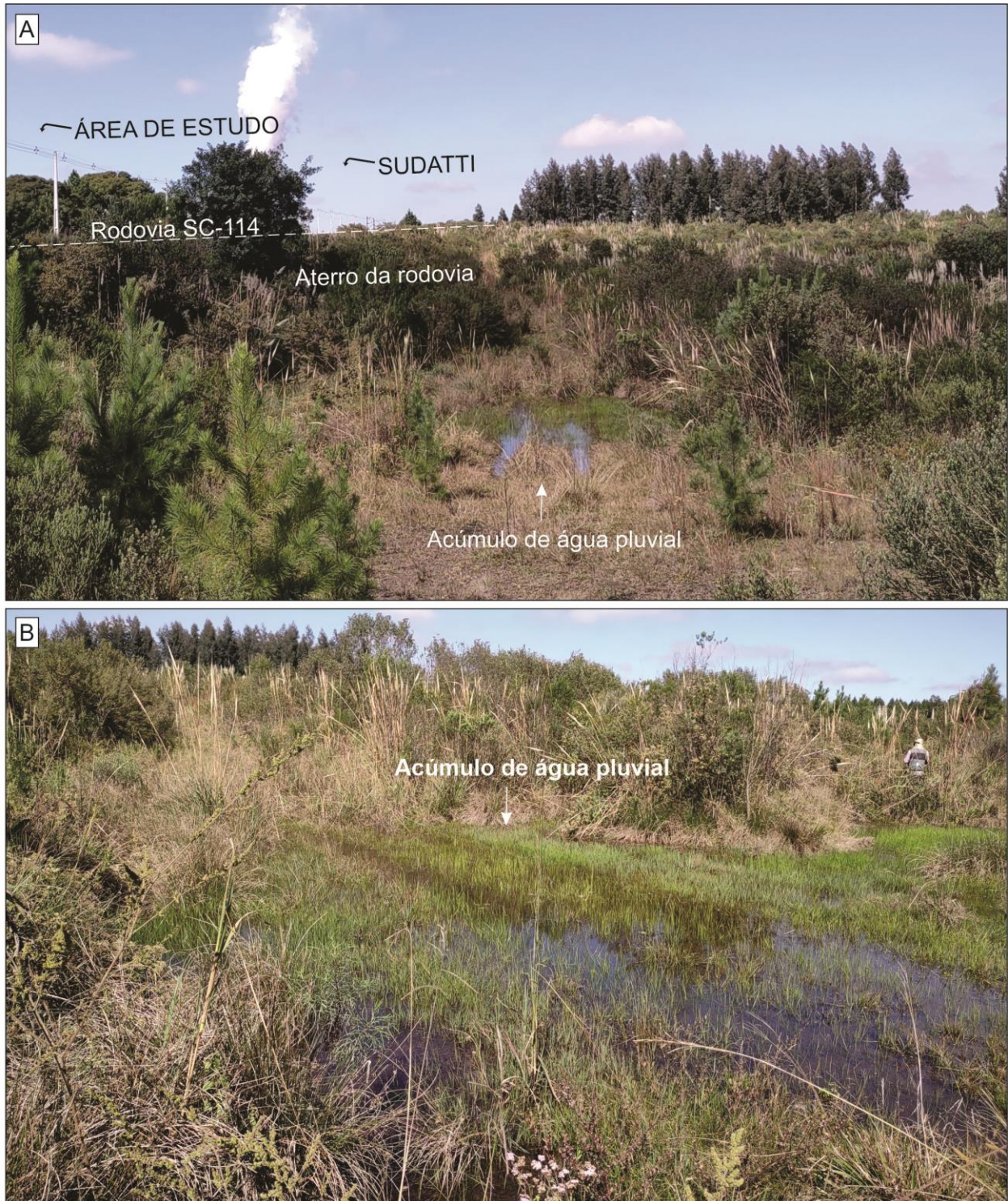
Foto 6. Área a montante do talvegue que foi seccionado pela Rodovia SC-114. As fotos acima são do dia 20/04/2022 após período de chuvas mostrando o acúmulo de água derivado do barramento do aterro da rodovia. A) Foto com indicação dos elementos físicos e estruturas do entorno. B) Detalhe do acúmulo de água. Observar que abaixo do nível de água a vegetação gramínea está bem estruturada, com tonalidades verdes indicando que a área em períodos sem chuva torna-se seca.
