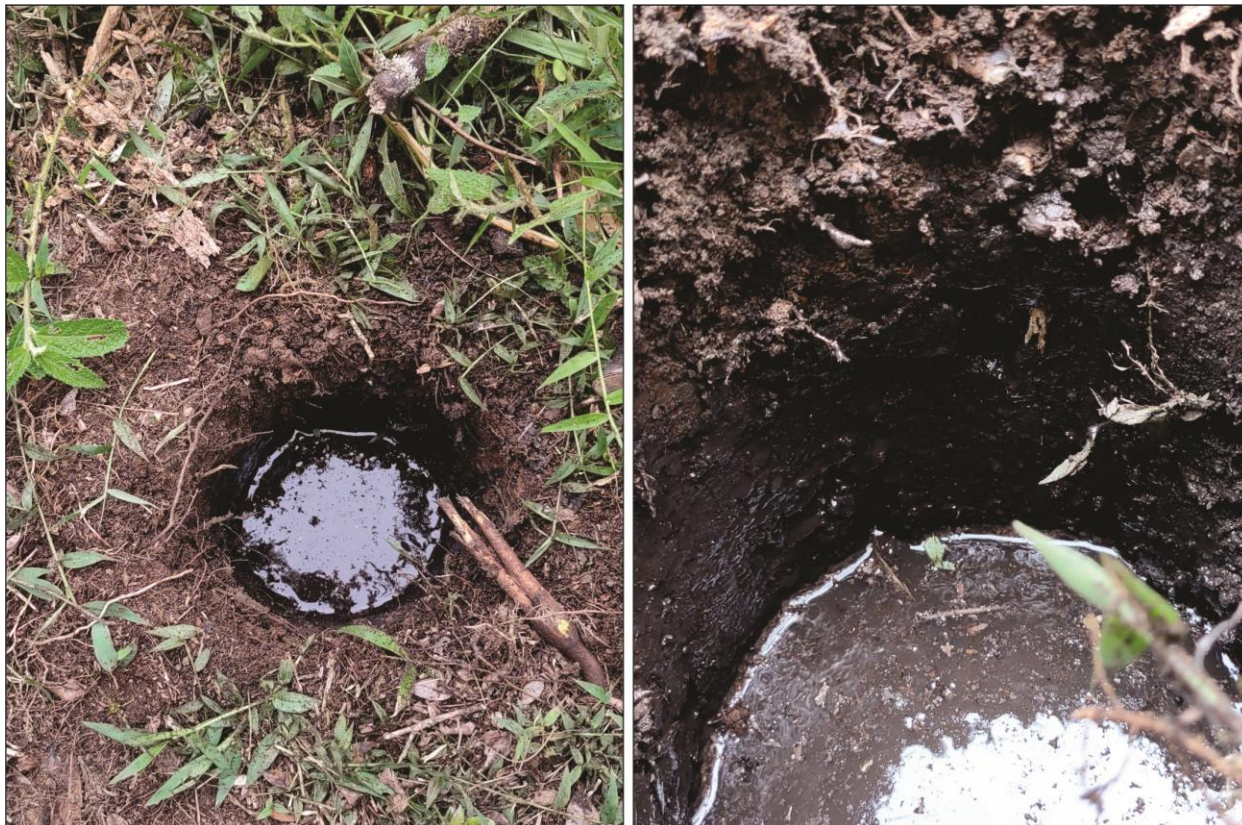
Foto 13. Execução de sondagens de reconhecimento geológico para avaliar a profundidade do nível de água freática (586902 m E/ 6961295 m S).
