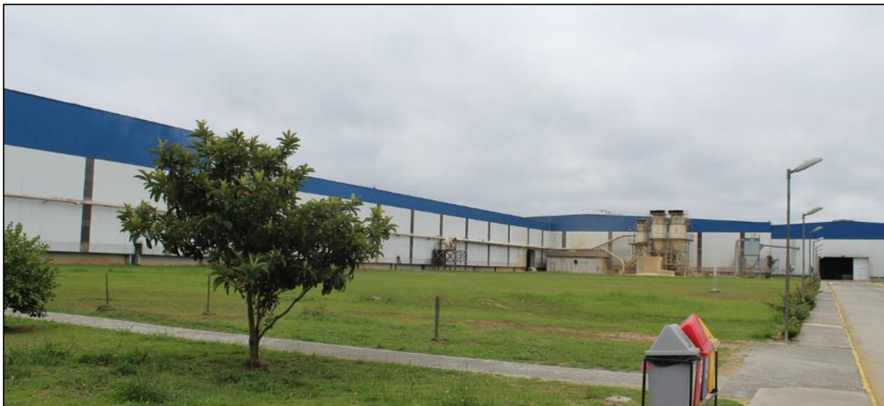
Foto 01 – Local previsto para instalação do Canteiro de Obras.
