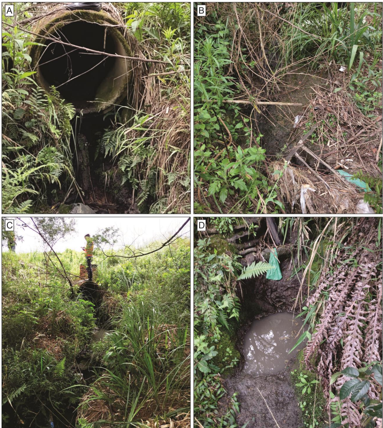
Foto 12. Área a jusante do ponto onde está indicada a presença da nascente no cadastro do SIGSC em período sem chuvas. A) Terminal da tubulação sem fluxo de água. B) Parcela da ravina sem fluxo de água e com detritos. C e D) sequencia jusante da ravina sem fluxo de água, mas com áreas mais profundas onde a água da chuva fica acumulada.
