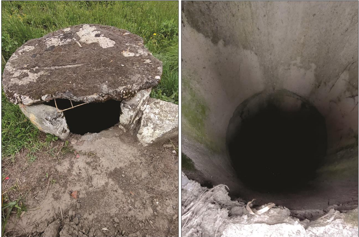
Foto 9. Ponto onde está indicada a presença da nascente no cadastro do SIGSC. Foto da esquerda mostra o aspecto da caixa de passagem com abertura lateral que dá acesso à água pluvial oriunda da Rodovia SC-114. Foto da direita destaca a parte interna da caixa de passagem onde se observa localmente a tubulação de fundo que recebe a drenagem pluvial dos telheiros e pátio da indústria.
