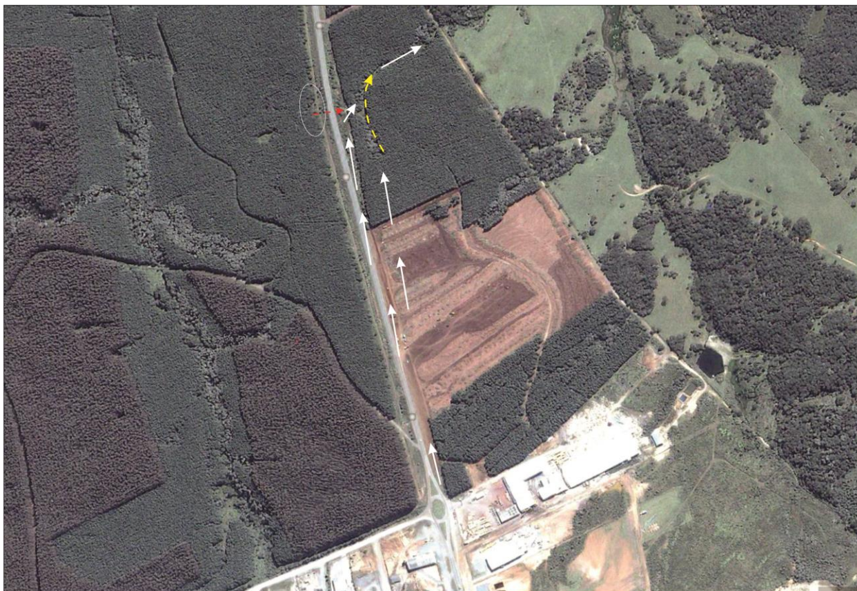
Figura 17. Comportamento da drenagem pluvial ao longo do eixo da rodovia antes da implantação da indústria SUDATI em 2007 (Fonte imagem: GoogleEarth). A seta amarela pontilhada representa a ravina gerada no talude sul do talvegue em função da alteração dos fluxos de água pluvial após a implantação do aterro da rodovia. A elipse branca representa a área onde ocorre acúmulo de água pluvial (Foto 6). A seta pontilhada em vermelho indica a tubulação implantada sob a rodovia (Foto7).
