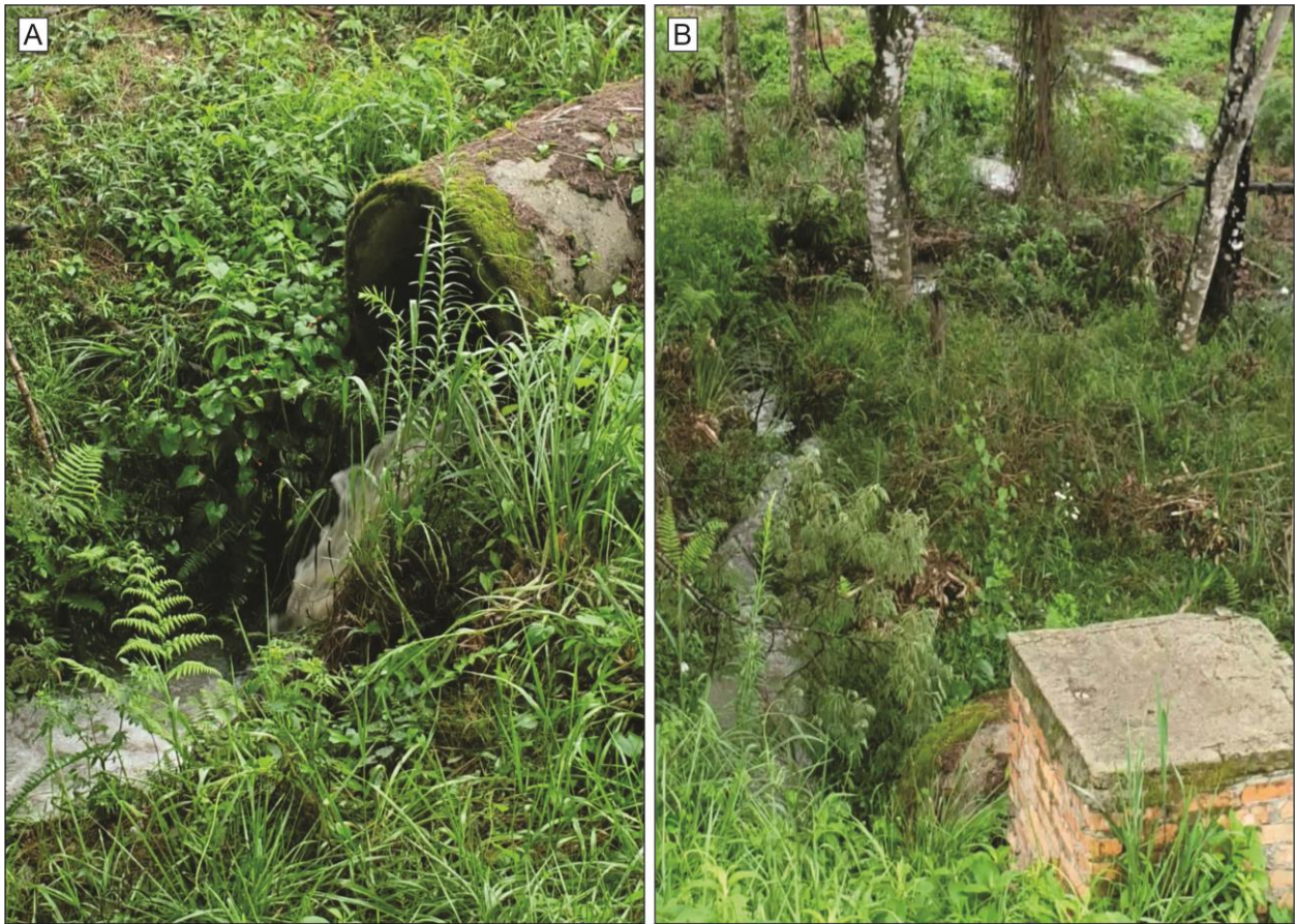
Foto 11. Chuva registrada em 10/03/2022. A) Terminal da tubulação com fluxo episódico da água pluvial do sistema de drenagem da Rodovia SC-114 e da indústria. B) escoamento superficial da água pluvial na ravina da área de estudo.
