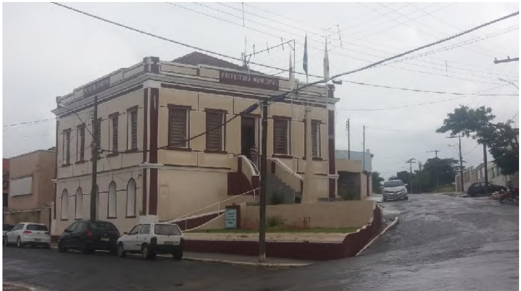
Figure 77 – Estrela do Sul city hall. Source: Pöyry Tecnologia (2018).
