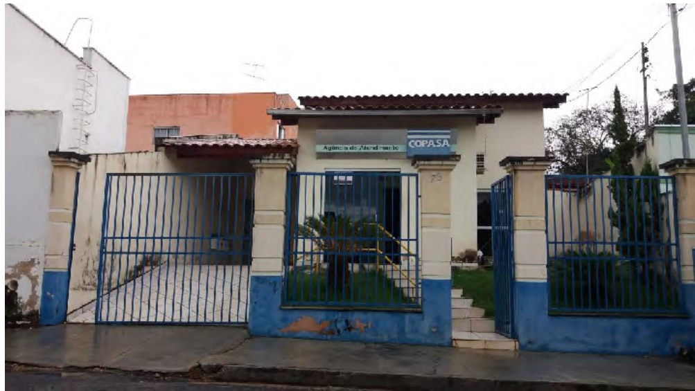
Figure 39 – COPASA agency in Estrela do Sul. Source: Pöyry Tecnologia (2018).
