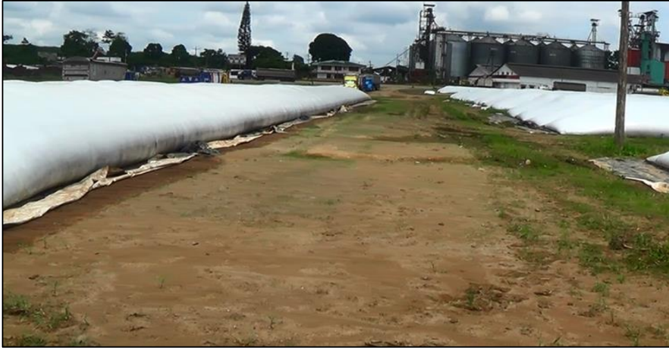
Imagen 23 Área de silos bag
