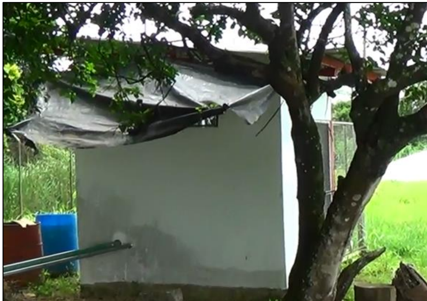
Imagen 22 Casa de bombas
