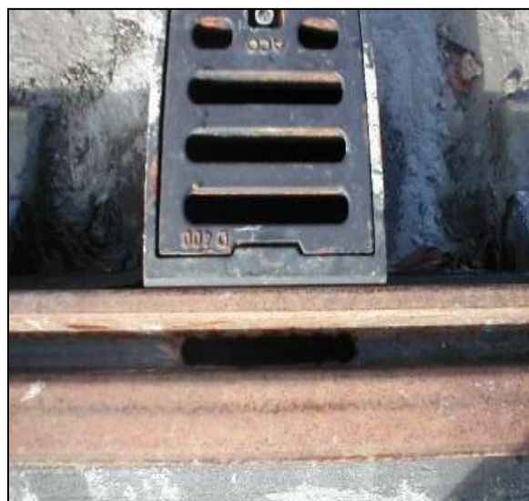
Figure 11 : Caniveau de drainage et boîte de drainage avec grille verrouillée
