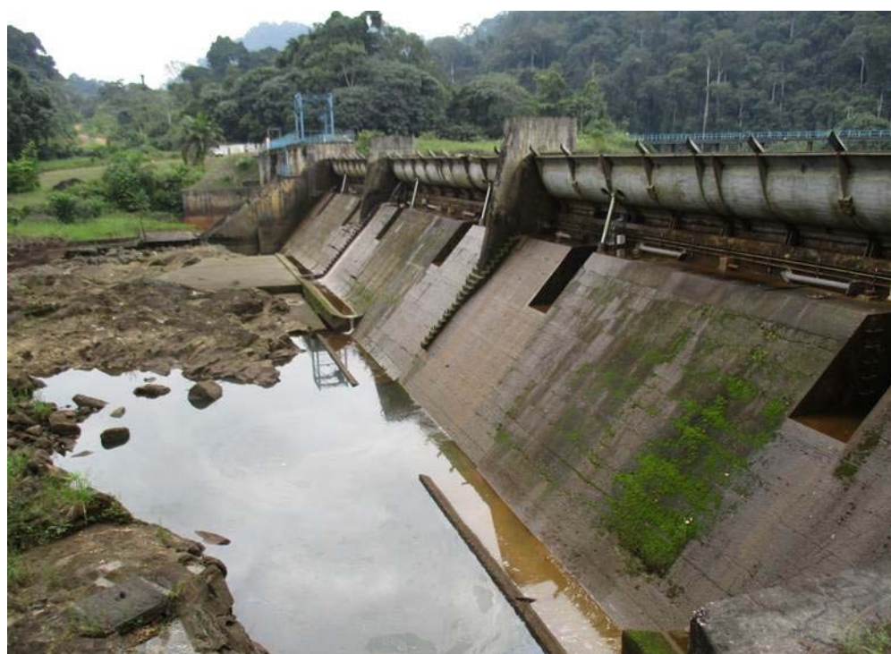
Photo. 22. Chute de Kingulé au pied du barrage
