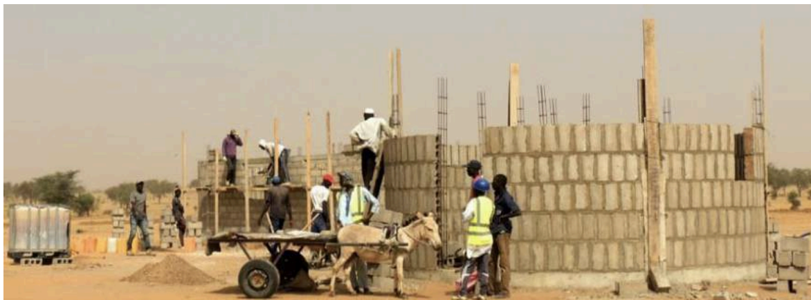
Campement éco-tourisme en construction en 2017-2018.
