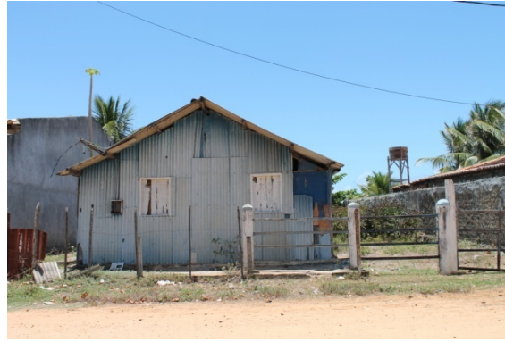
Foto 7.5-1: Casa 5 Que Atualmente Encontra-Se Demolidada
