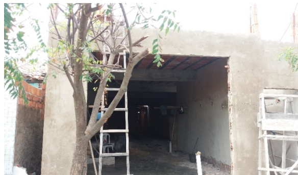
Foto 7.4-2: Visita De Acompanhamento Social Na Nova Casa / Comércio Do Anísio Que Está Sendo Construída Na Praia De Jatobá
