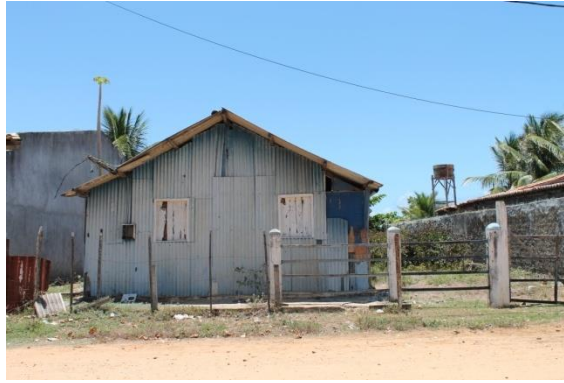
Foto 7.3-61: Casa 5 que atualmente encontra-se demolida
