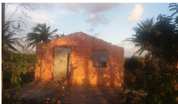
Foto 7.3-50: Casa 1 – Benfeitoria 2 na Praia de Jatobá que pertence ao ██████████ está desocupada e liberada para demolição
