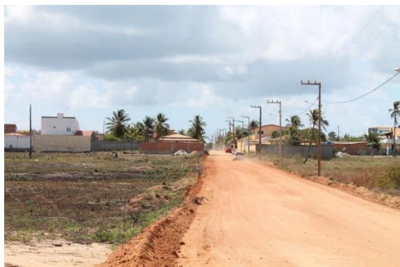
Foto 7.3-31: Vista do Loteamento Praia do Porto, Praia do Jatobá
