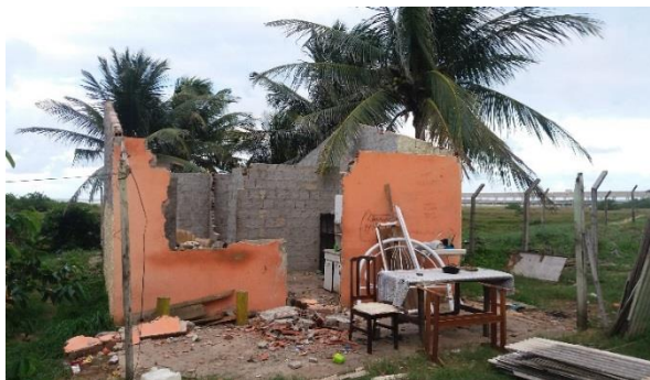
Foto 7.3-48: Casa 1 – Benfeitoria 1 na Praia de Jatobá que pertence ao ██████████ está desocupada e liberada para demolição
