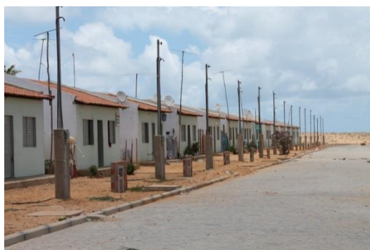
Foto 7.3-91: Construção de moradias populares para as famílias, CRQ Pontal da Barra.
