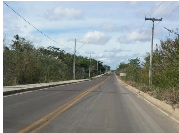
Foto 7.3-18 - Rodovia vicinal cruzada pela linha. No entorno verifica-se presença de vegetação nativa entremeada por coqueiros e vegetação exótica
