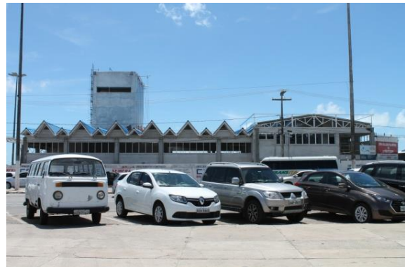
Foto 7.3-38: Obras de ampliação do Terminal Pesqueiro público de Aracaju
