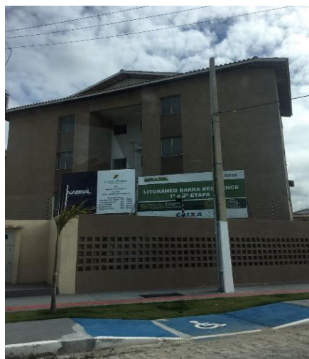
Foto 7.3-22: Condomínio Litorâneo Barra Residence - entregue fase 1 e a fase 2 está em acabamento
