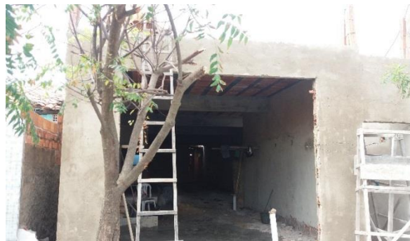
Foto 7.3-60: Visita de acompanhamento social na nova casa / comércio do [REDACTED] que está sendo construída na Praia de Jatobá
