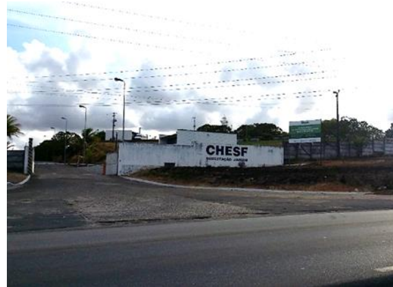
Foto 7.3-10 - Final do Traçado da LT, na Subestação Jardim da CHESF
