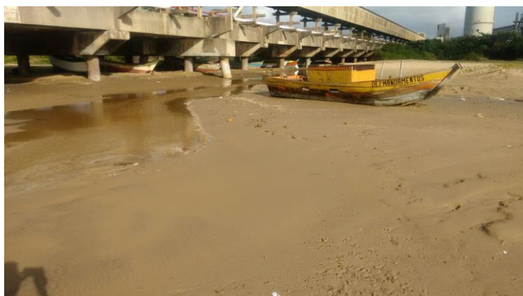
Foto 3.2.3-1: Local de armazenamento das embarcações (canoas) sob a ponte de acesso ao TMIB. Fonte: Lino & Cosso, 2017.
