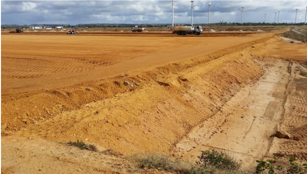
Foto 7.1-1: Área do Empreendimento, cuja camada superficial foi removida, em torno de 60 cm, e recolocado noca camada areno-argilosa com recompactação
