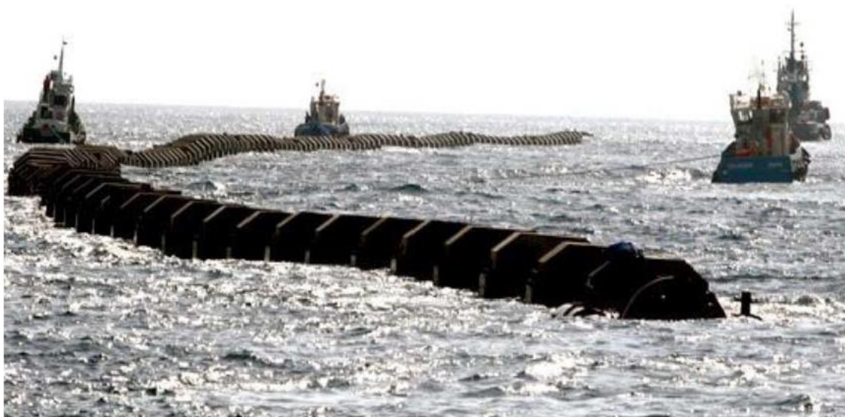
Foto 3.2-1: Segmento de duto sendo transportado em flutuação por rebocadores
