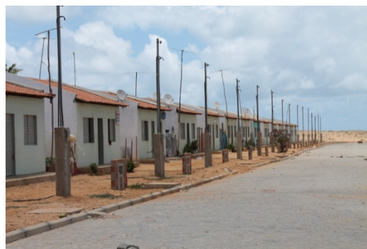
Foto 7.3-52: Construção de moradias populares para as famílias, CRQ Pontal da Barra (CH2M, fev/17).
