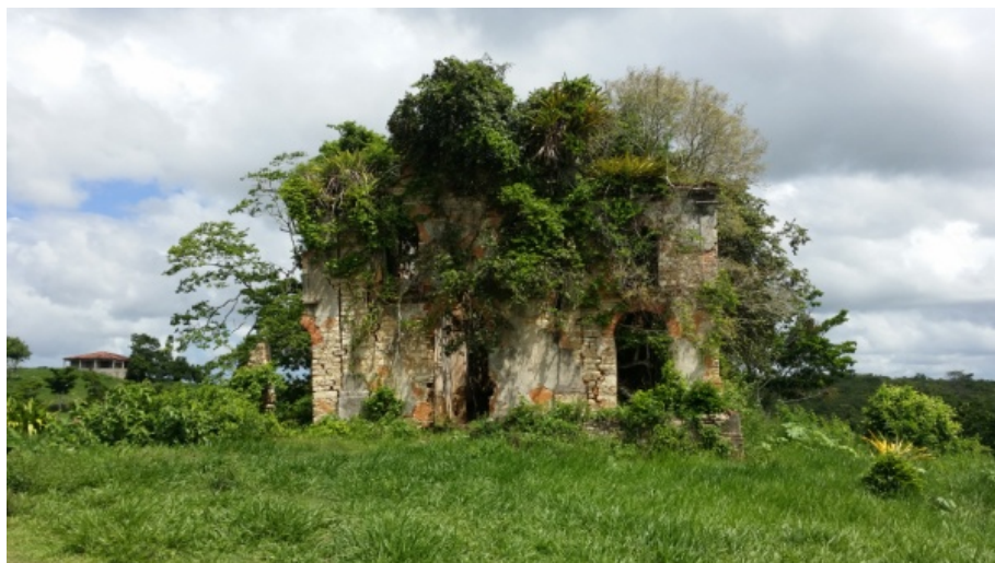
Foto 7.3-55: Ruína de uma Igreja localizada próxima ao traçado da LT 500kV, município de Laranjeiras/SE (CH2M, jun/17)
