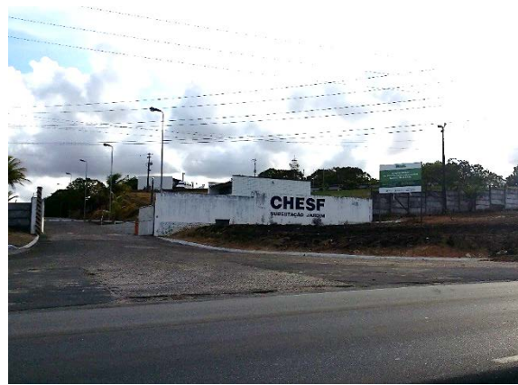
Foto 7.3-2 - Final do Traçado da LT, na Subestação Jardim da CHESF
