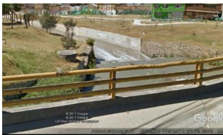
Figura 2-6 Puente Quebrada Chigüaza Fuente. Consorcio Troncal Caracas, 2017
