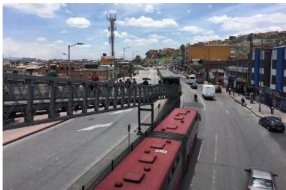
Fotografía 2-1. Sección Vía Antes de Estación Molinos Fuente. Equipo Consultor.
