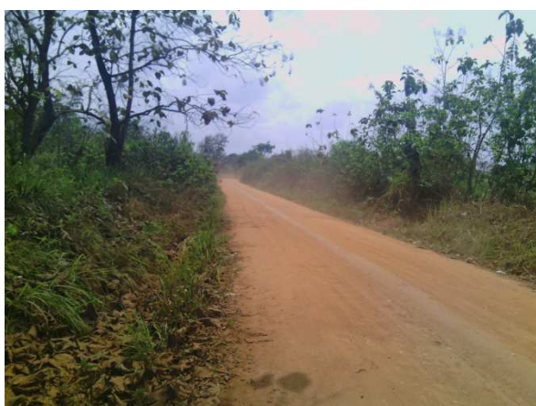
Figure 1 Route en terre à proximité du site de la base vie
