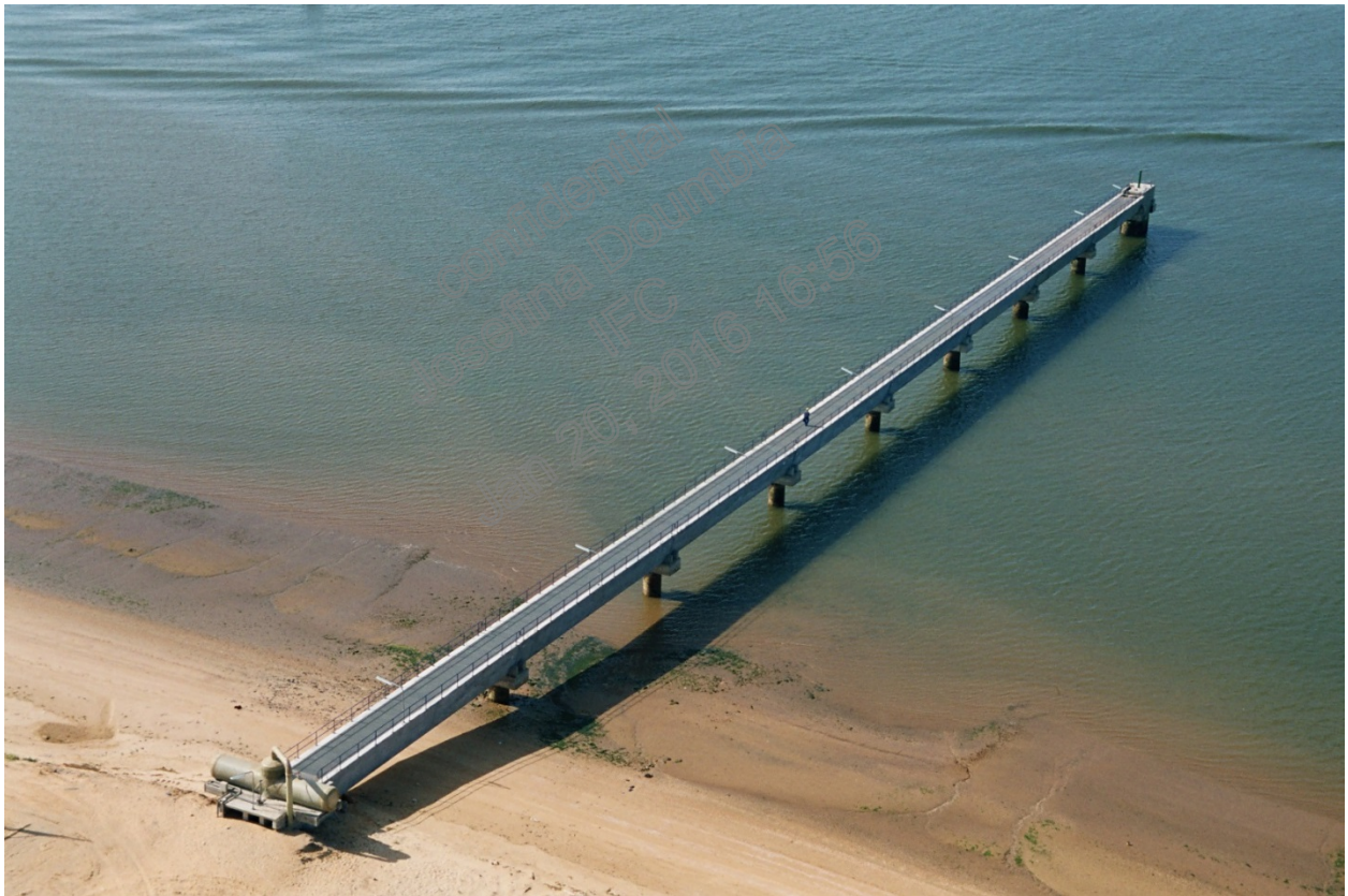
Figura 12. Vista aérea del pantalán de captación, con la campana de captación en el extremo en el mar y la instalación de regulación para el efecto sifón en la zona de la playa
