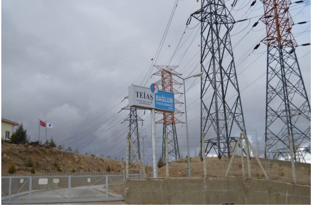
Şekil 5. Proje Alanı Fotoğrafları (Bağlum Trafo Merkezi)
