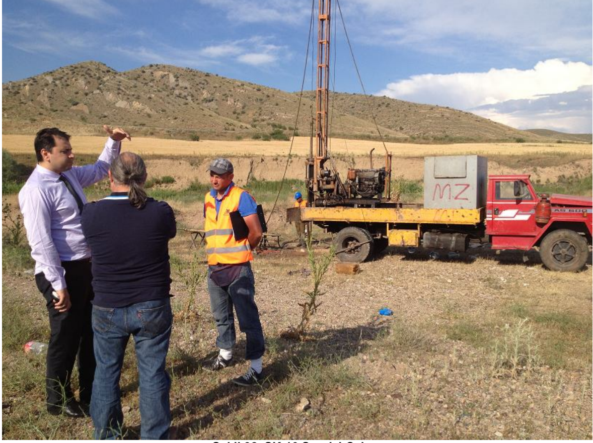
Şekil 32. SK-10 Sondaj Çalışması
