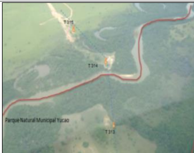
FOTOGRAFÍA PMAB-2.6-1 SITIO DE TENDIDO DE CABLE. PARQUE NATURAL MUNICIPAL YUCAO
