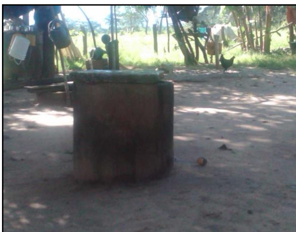
FOTOGRAFÍA 4.5 ALJIBE CUNARICHE- CUENCA RIO TACUYA VIEJO
