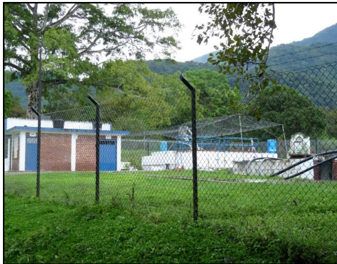
FOTOGRAFÍA 3.78 ACUEDUCTO MUNICIPAL SAN LUIS DE GACENO Fuente: Grupo G.I 2010.
